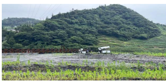
矸石堆场水雾喷淋设施
