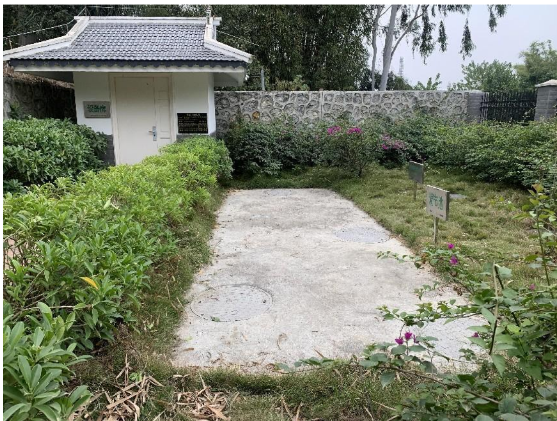
污水处理站景观绿化照片
