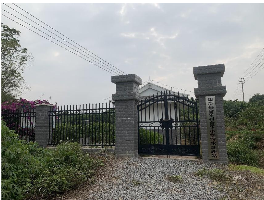
污水处理站现状照片
