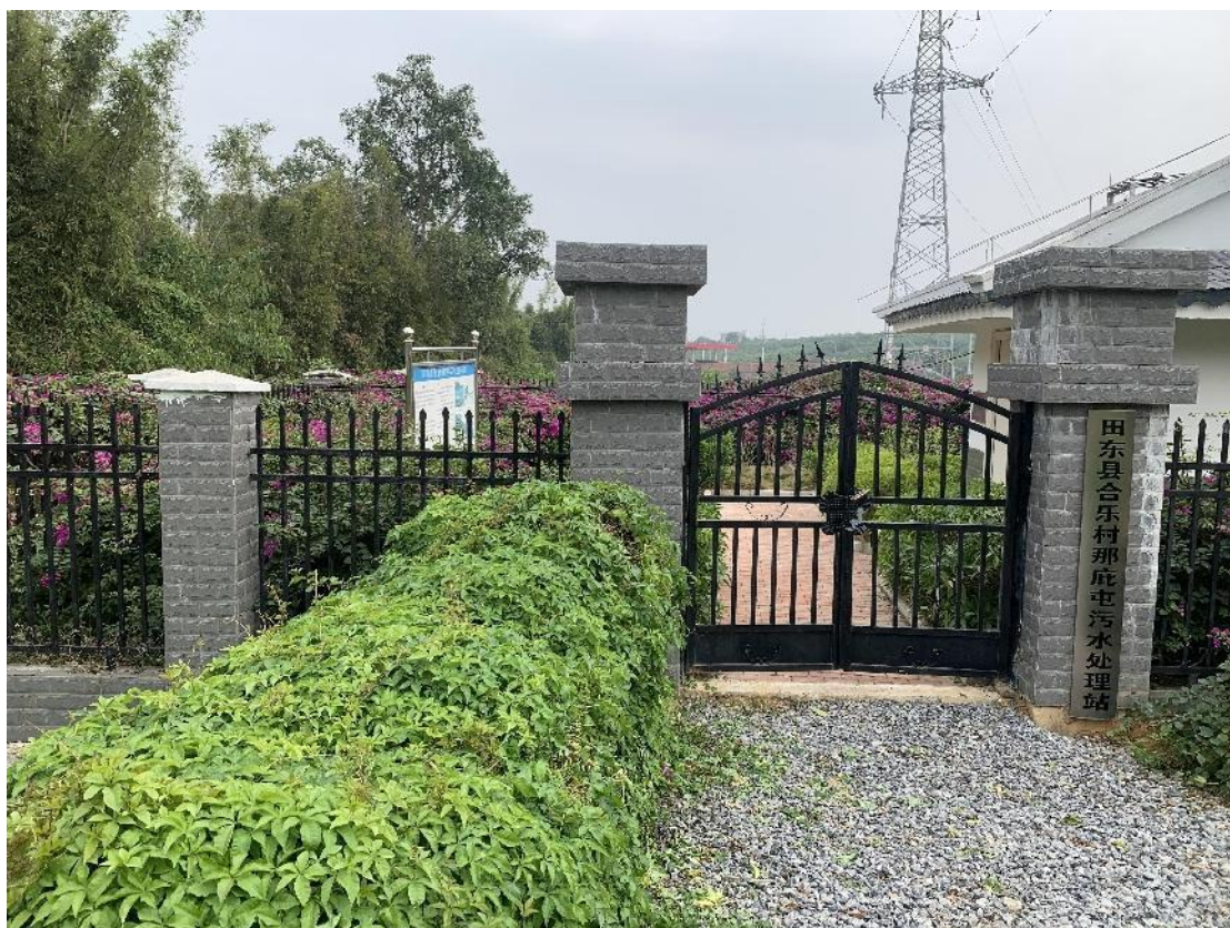
污水处理站现状照片
