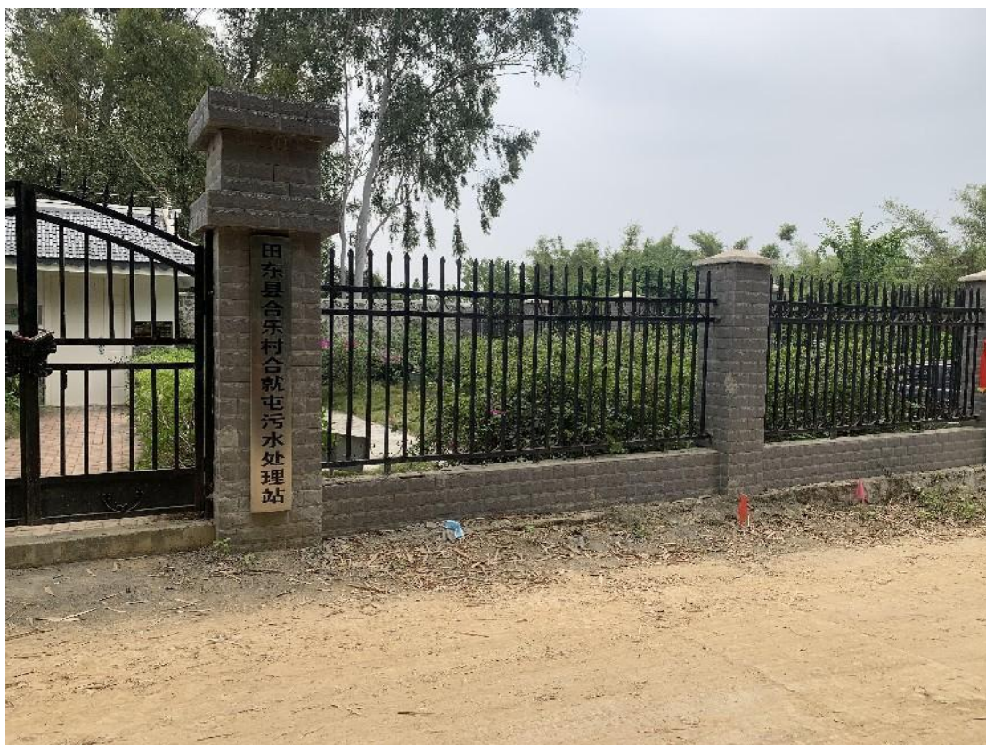
污水处理站现状照片
