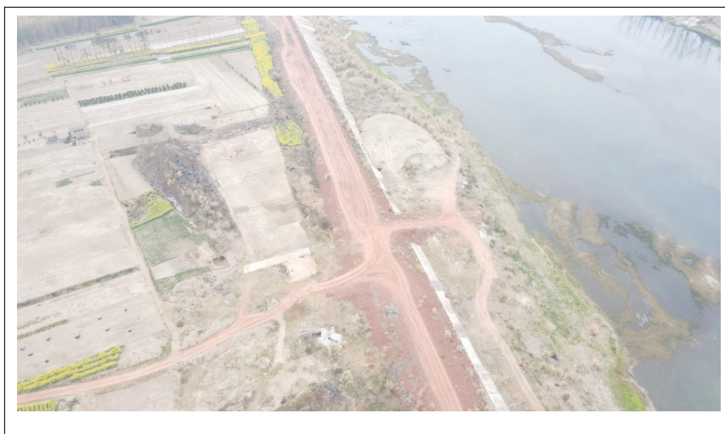
图 3.3-1 施工道路区本季度现场图
