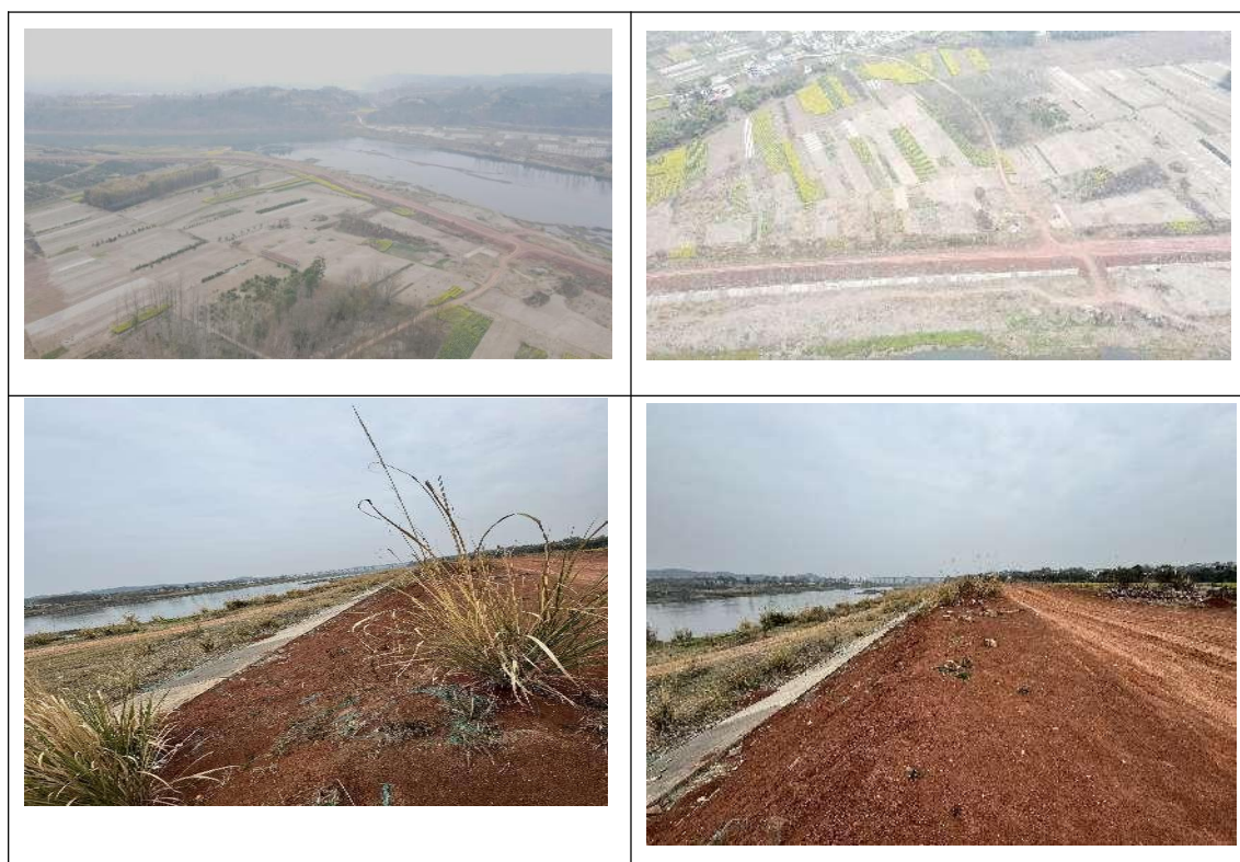
图 3.2-1 主体工程区本季度现场图
