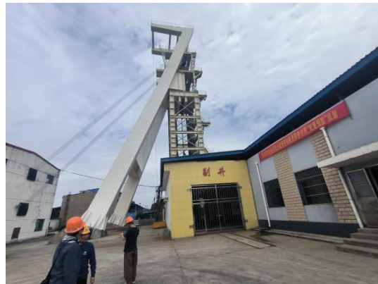
图 3.1-3 安庆铜矿副井现状
