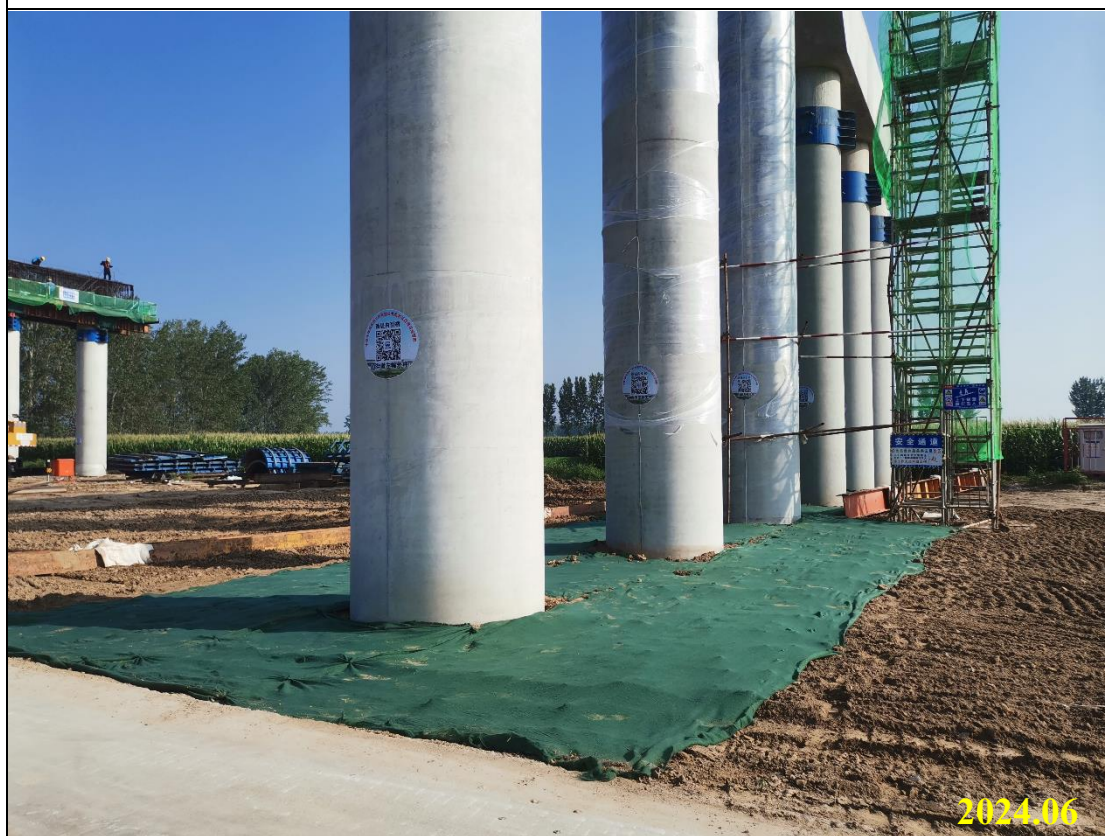
桥下裸露开挖面临时苫盖
