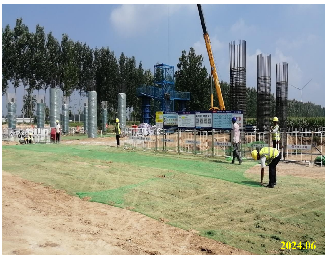
路基裸露面进行覆盖
