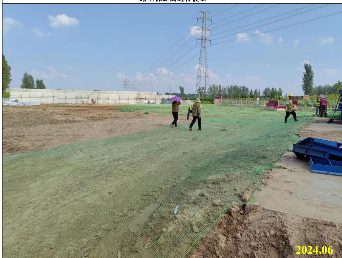
路基裸露面进行覆盖
