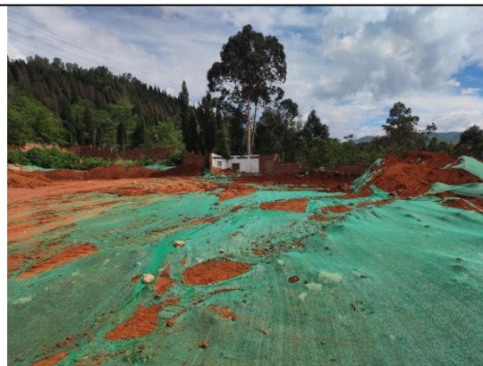
剥离表土及临时覆盖（表土已利用）
