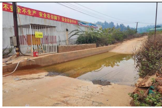
道路及硬化区监测点
