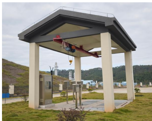
污水收集池加盖
