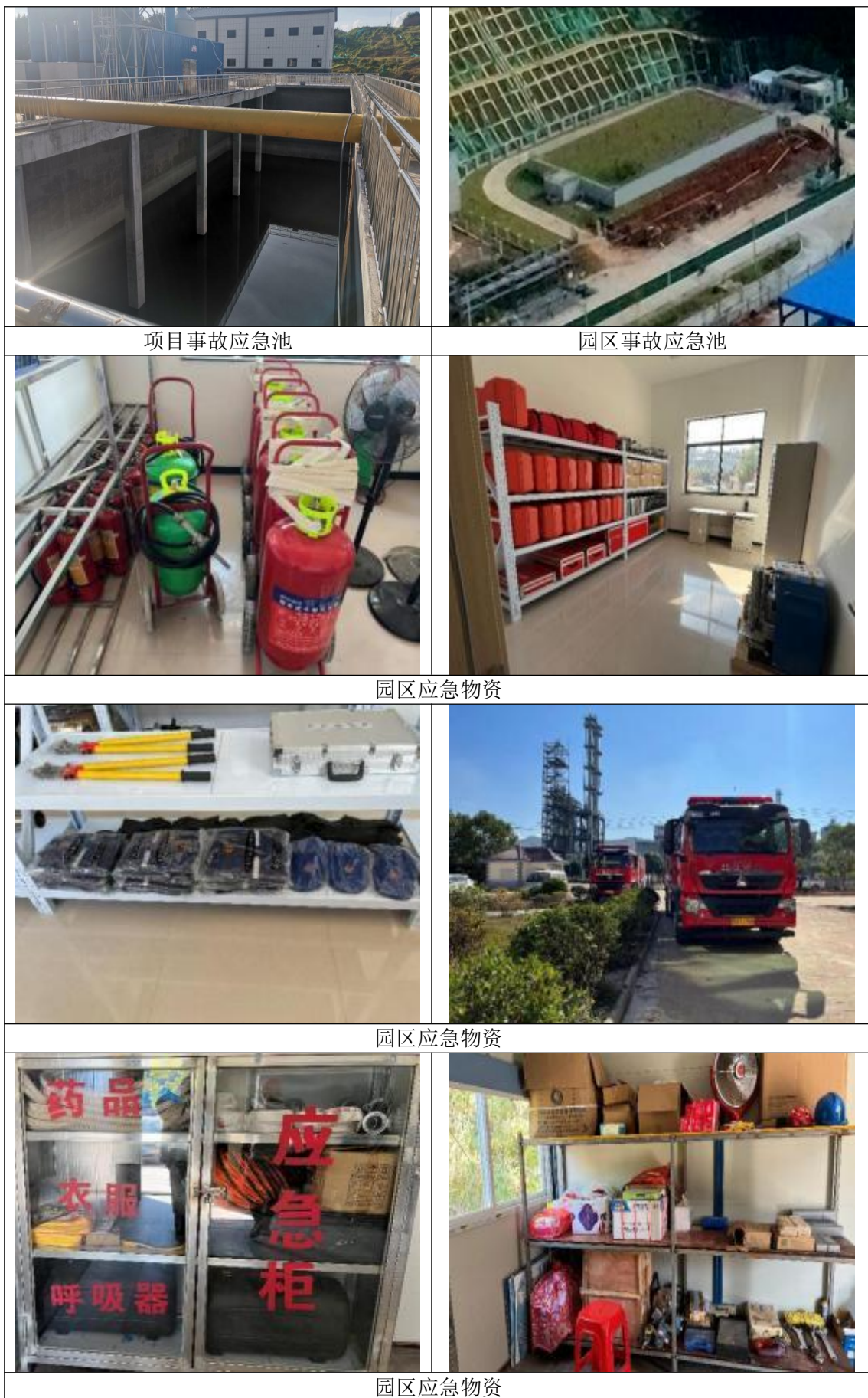
图 4-9 项目环境风险防控措施现场照片
