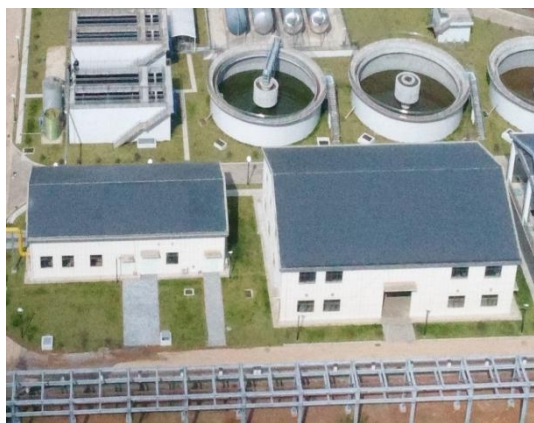
配电间及风机房、加药间厂房隔声
