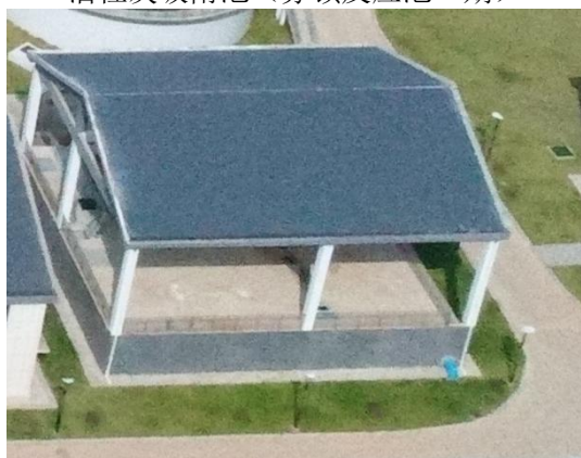
精密过滤池+接触消毒池
