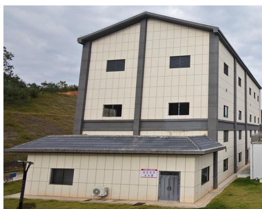
污泥脱水车间厂房隔声
