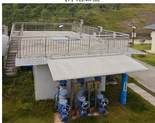
污泥泵井加盖
