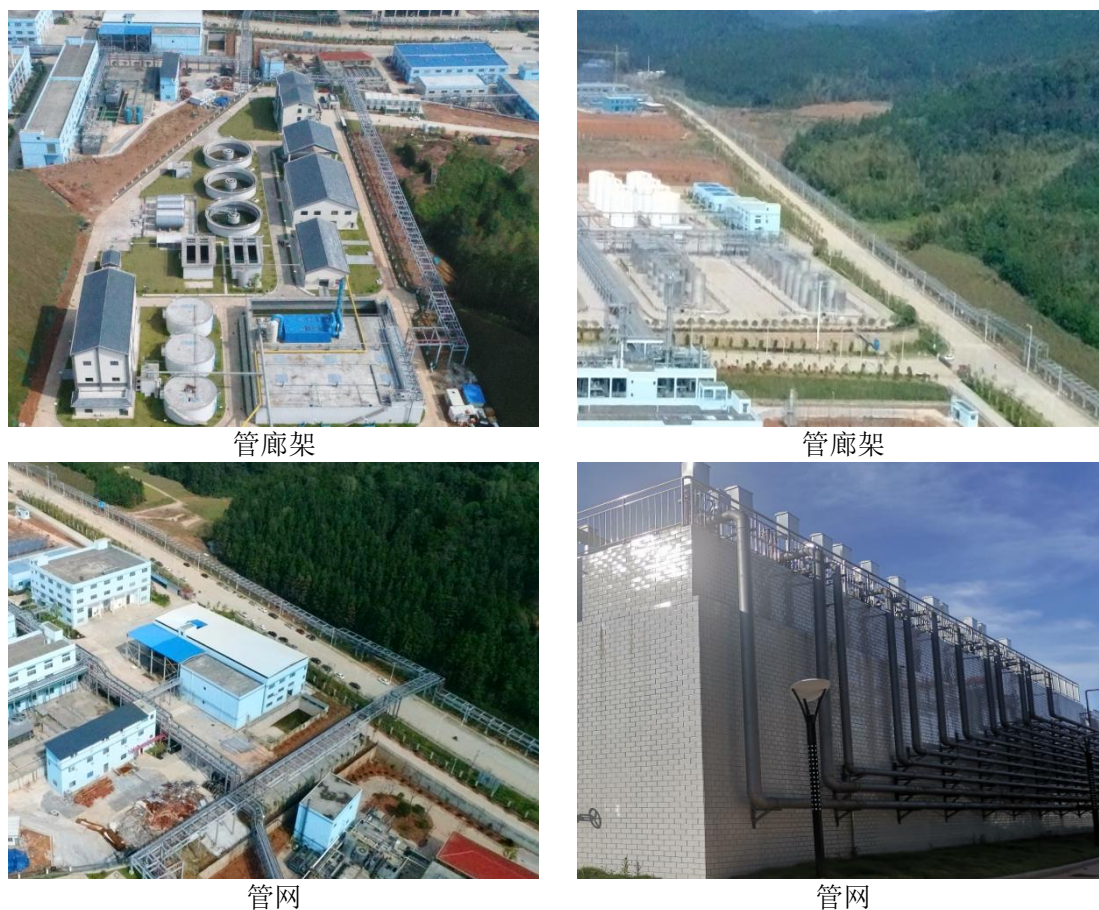
图 4-1 废水收集管廊架、管网
