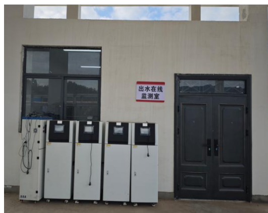
出水口在线监测站房外
