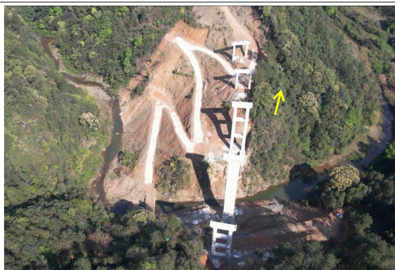
元宝山连接线 LCK1+200 桥梁工 程
