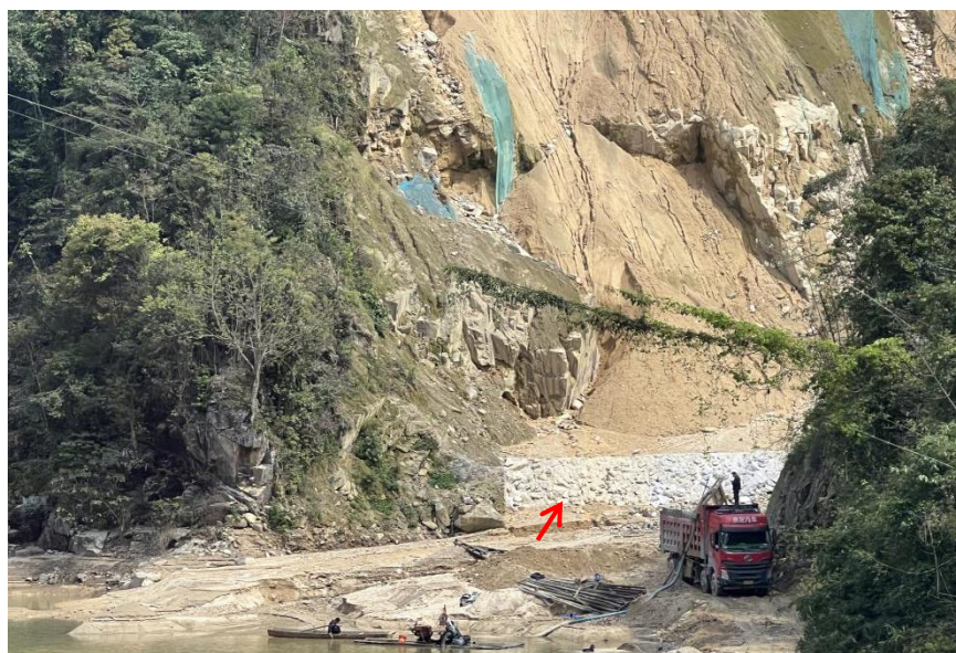
九溪村大桥 桥台边坡坡 底新增拦渣 墙
