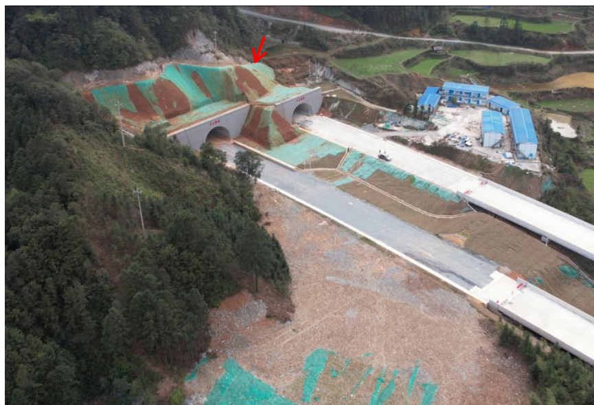
安太隧道出口新增喷播 草籽和密目 网苫盖
