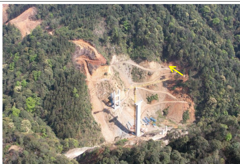
元宝山连接线 LCK1+815 桥梁工 程
