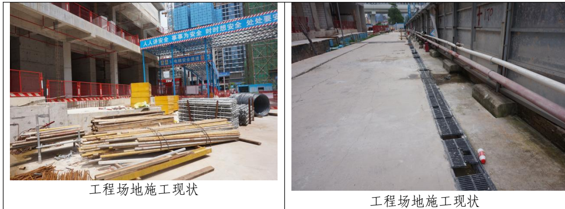
图 3-14 施工过程中监测影像（2021 年 6 月）
