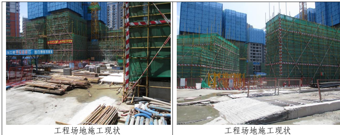
图 3-12 施工过程中监测影像（2021 年 4 月）
