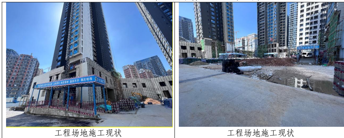
图 3-25 施工过程中监测影像 (2022 年 9 月)
