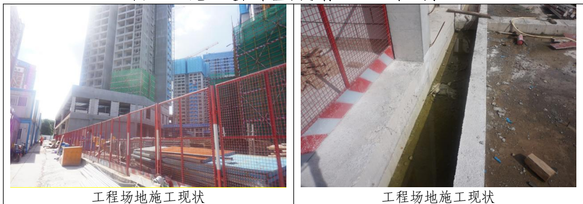
图 3-16 施工过程中监测影像（2021 年 8 月）
