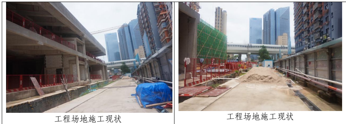
图 3-15 施工过程中监测影像（2021 年 7 月）
