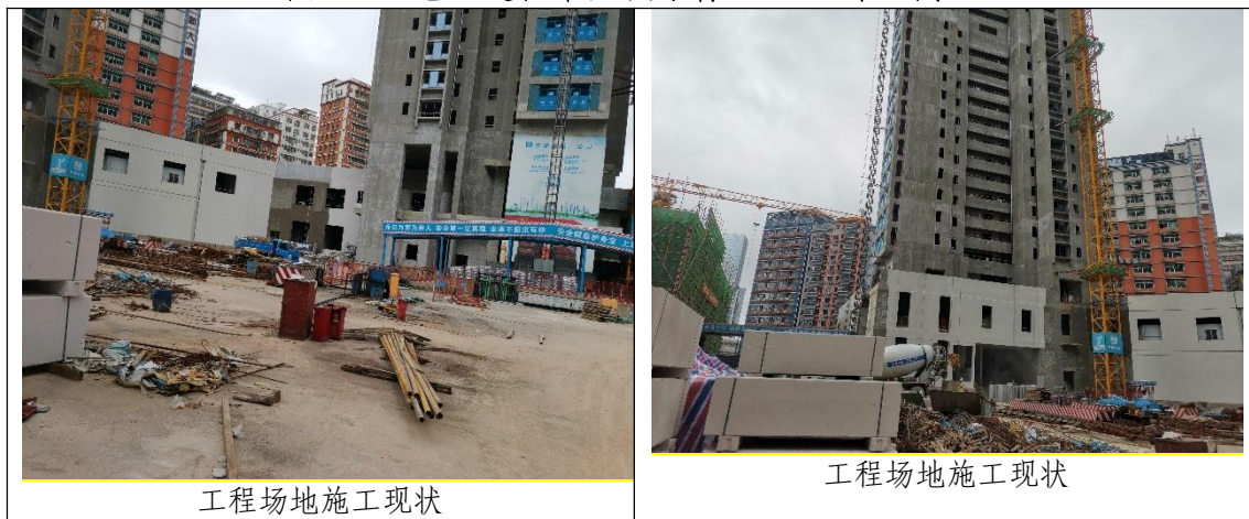
图 3-21 施工过程中监测影像（2022 年 5 月）
