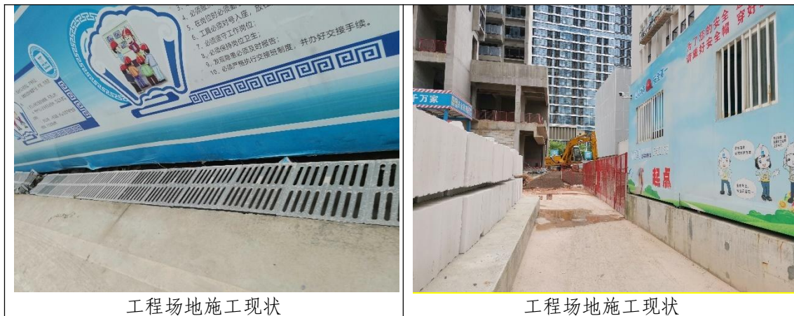
图 3-20 施工过程中监测影像（2022 年 4 月）
