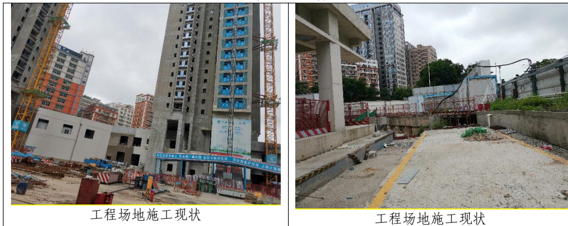
图 3-22 施工过程中监测影像（2022 年 6 月）
