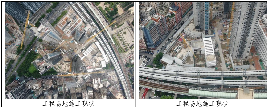
图 3-24 施工过程中监测影像 (2022 年 8 月)
