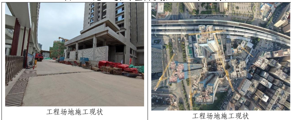
图 3-19 施工过程中监测影像（2022 年 3 月）
