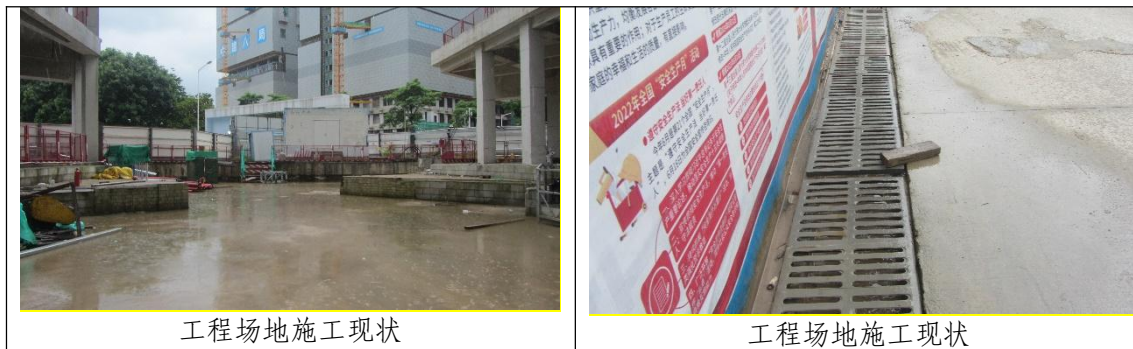
图 3-23 施工过程中监测影像 (2022 年 7 月)
