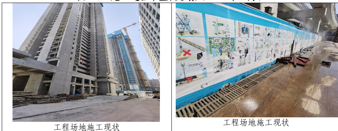
图 3-18 施工过程中监测影像（2021 年 12 月）
