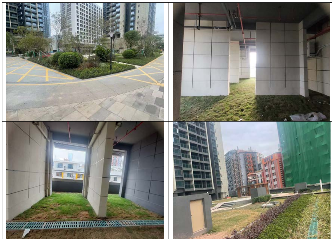
图 3-27 施工完工后监测影像（2023 年 10 月）
