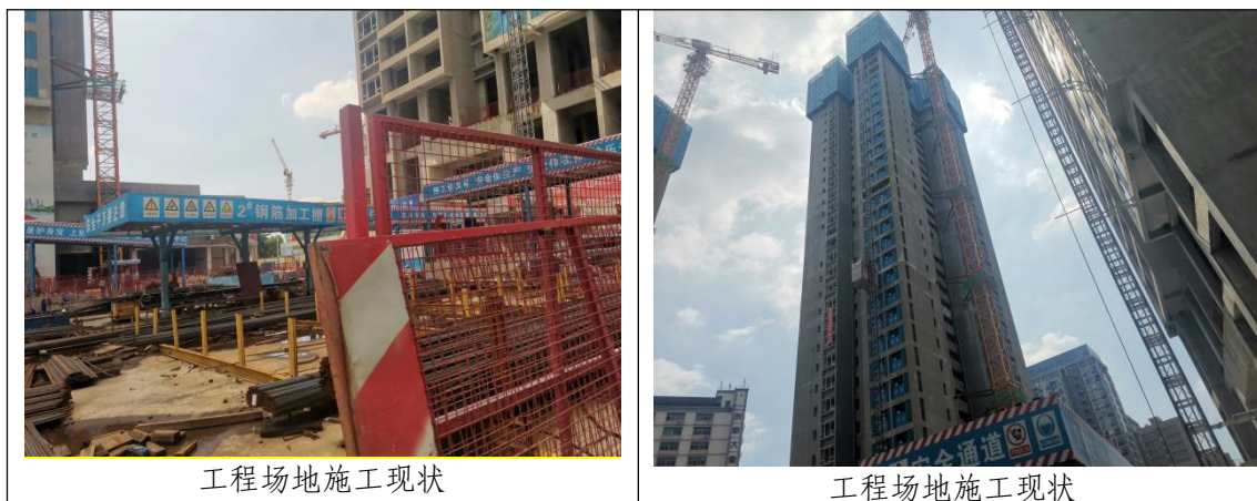
图 3-17 施工过程中监测影像（2021 年 9 月）
