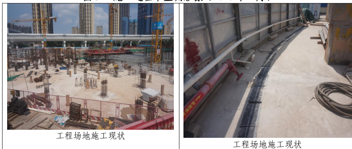
图 3-8 施工过程中监测影像（2020 年 8 月）
