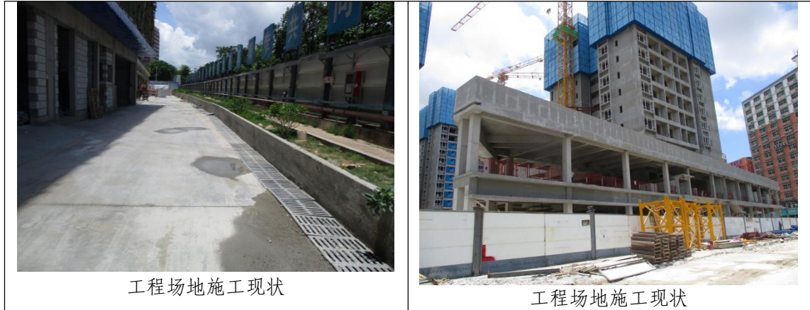
图 3-13 施工过程中监测影像（2021 年 5 月）
