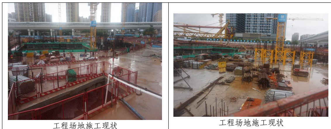
图 3-7 施工过程中监测影像（2020 年 7 月）
