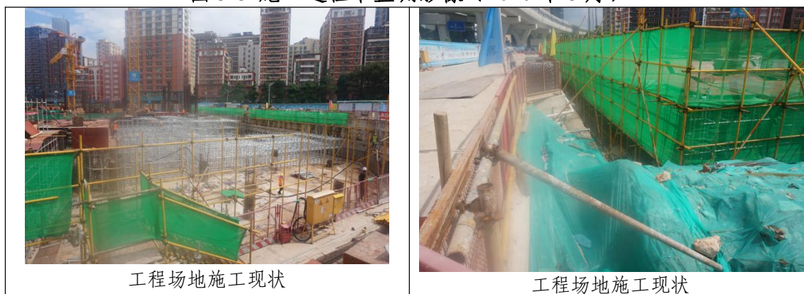
图 3-9 施工过程中监测影像（2020 年 9 月）
