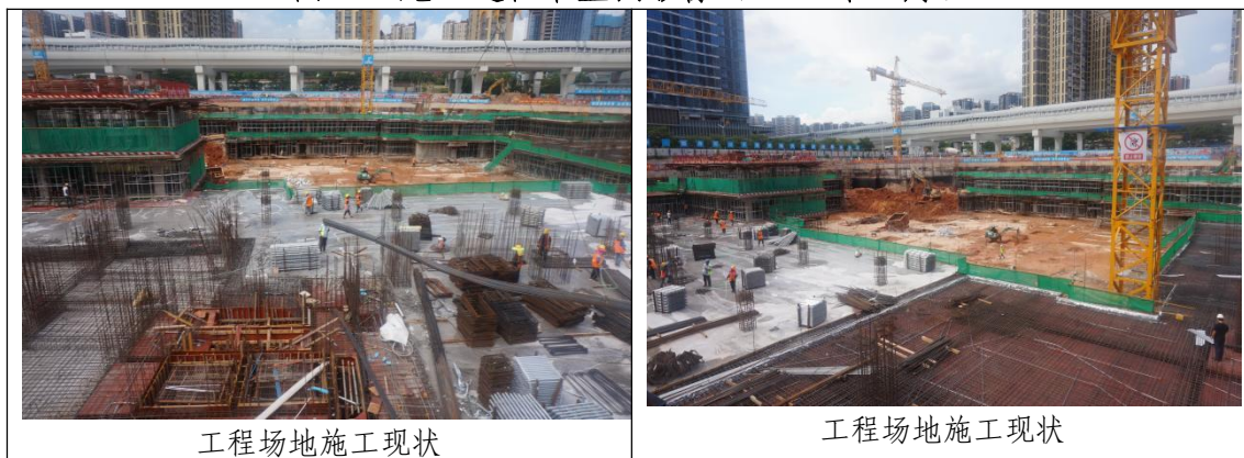
图 3-6 施工过程中监测影像 (2020 年 6 月)
