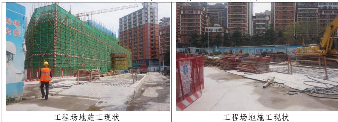
图 3-11 施工过程中监测影像（2021 年 3 月）
