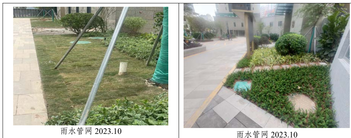
图 4-1 监测过程工程措施图
