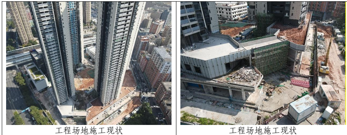
图 3-26 施工过程中监测影像 (2022 年 12 月)
