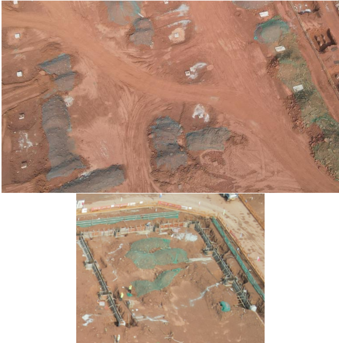
临时堆土场区
