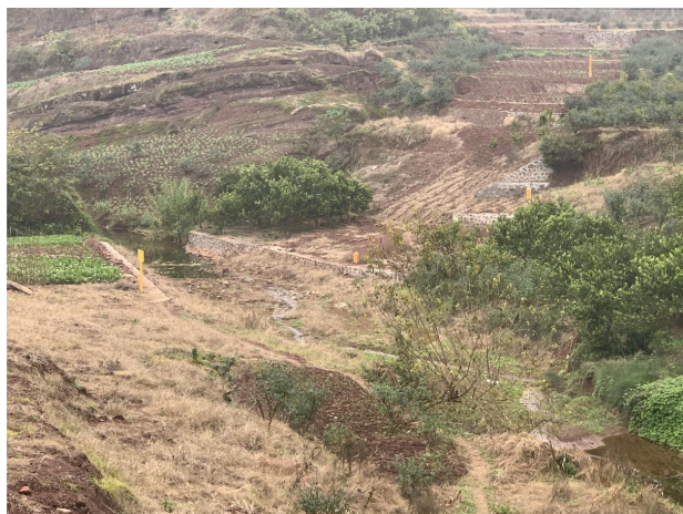
穿越刁夹小河现场照片
