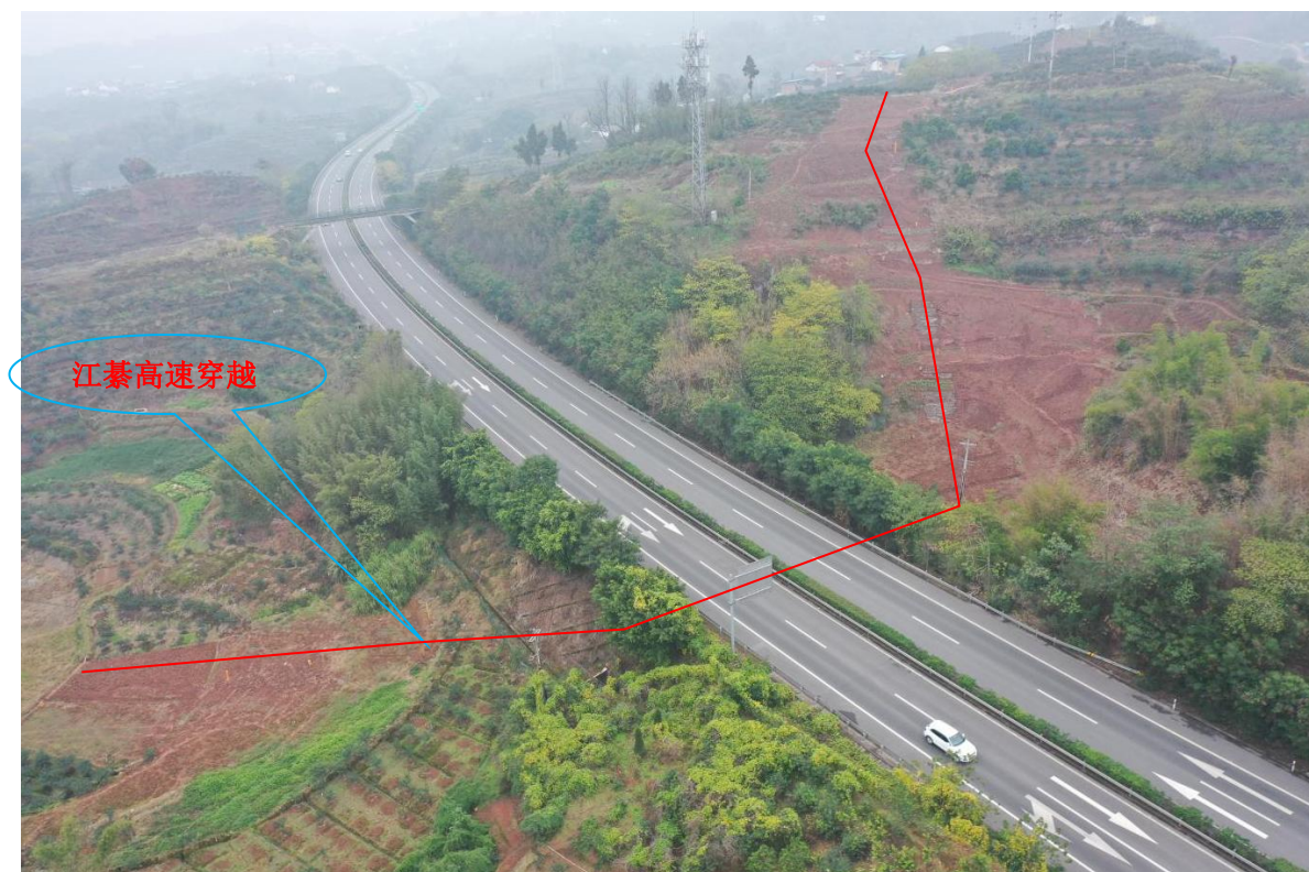
图 5.1-1 江碁高速穿越处现状照片
