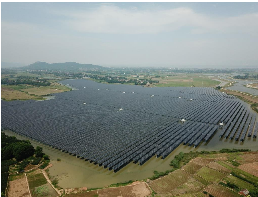
光伏阵列区建设后无人机航拍影像图
