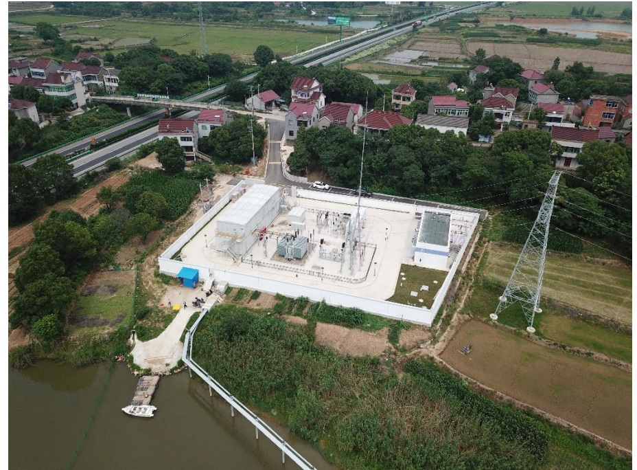
升压站区建设后无人机航拍影像图
