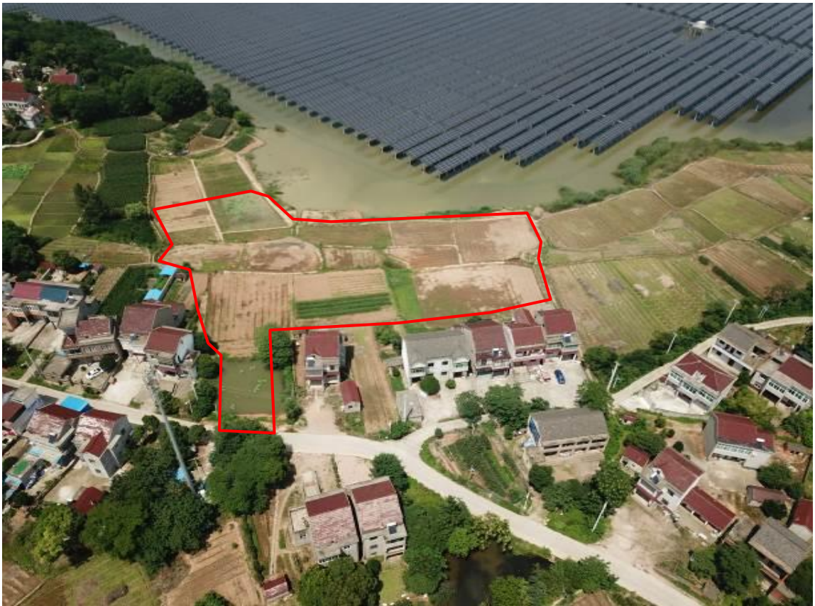
施工营地区现状情况图片
