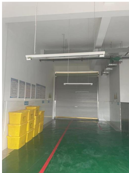
医疗废物暂存间
