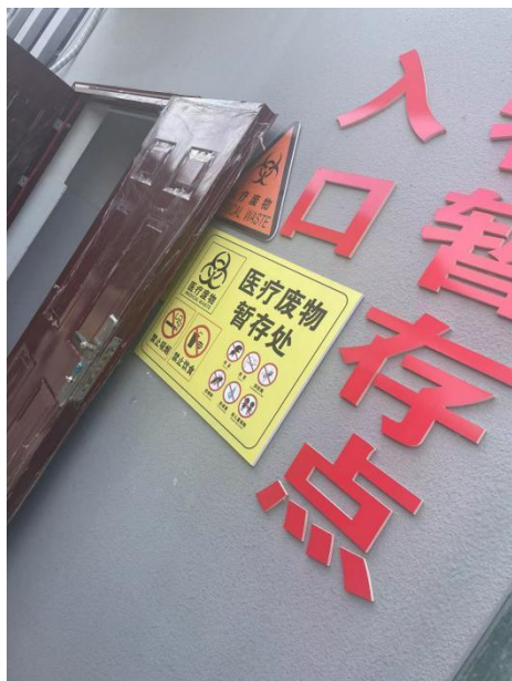
医疗废物暂存间
