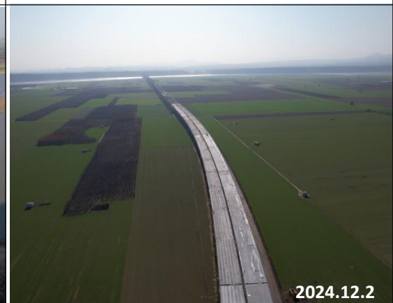
黄河特大桥桥下撒播草籽
