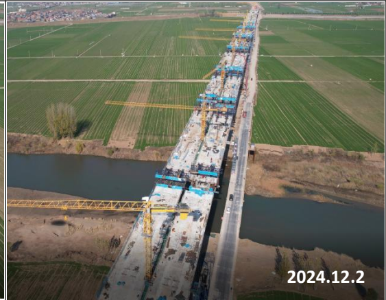
沁河特大桥主桥
