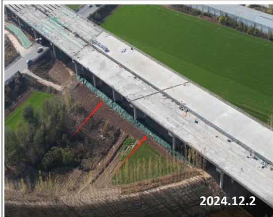
济河大桥桥下临时覆盖
