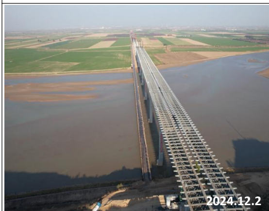
黄河特大桥主桥
