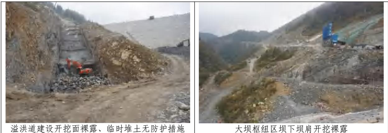
溢洪道建设开挖面裸露、临时堆土无防护措施
