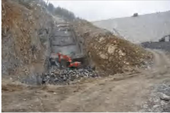
溢洪道建设开挖面裸露、临时堆土无防护措施
