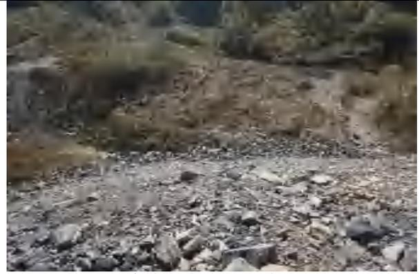
临时堆料场边坡裸露、部分坡脚无拦挡措施
