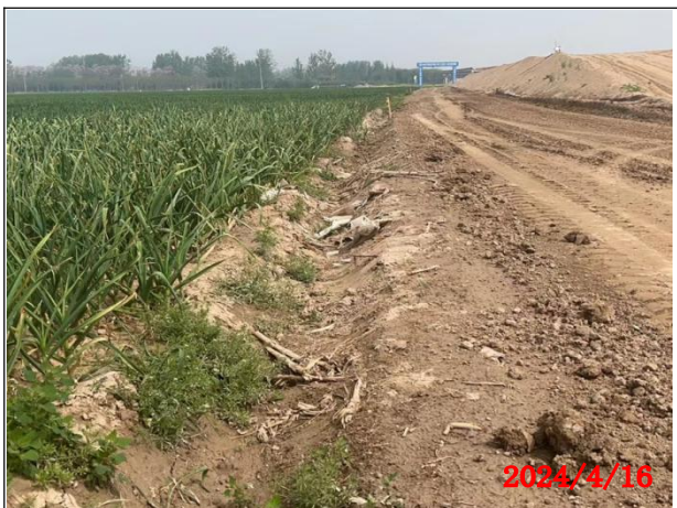
K0+700 施工便道
