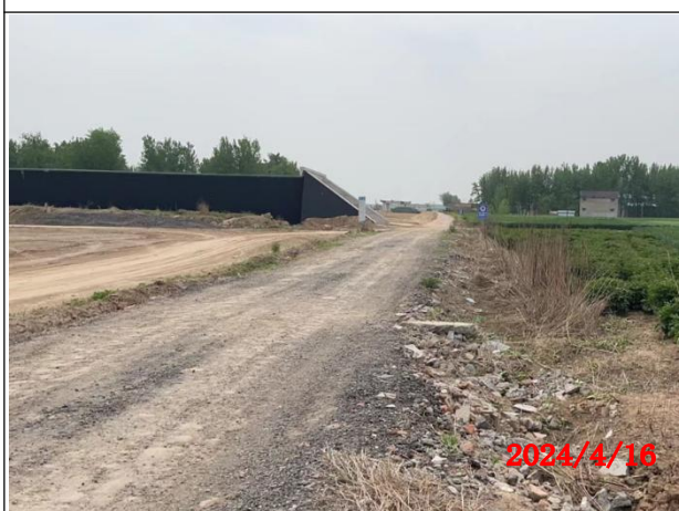
K75+300 施工便道
