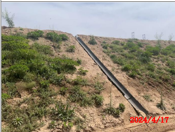
K105+600 路基边坡临时急流槽
