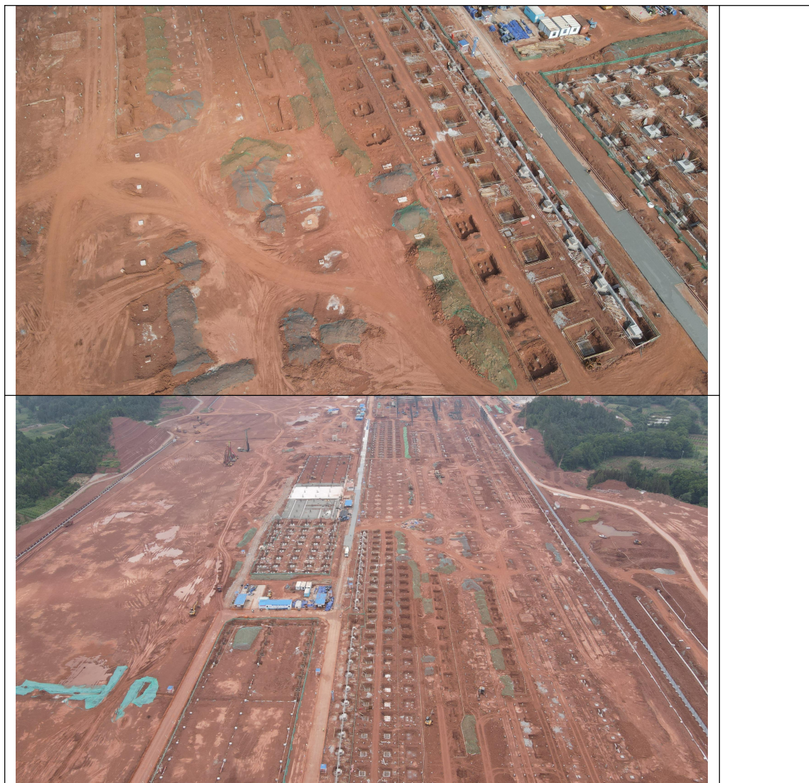
图 1.3-1 建构筑物工程区现状图
