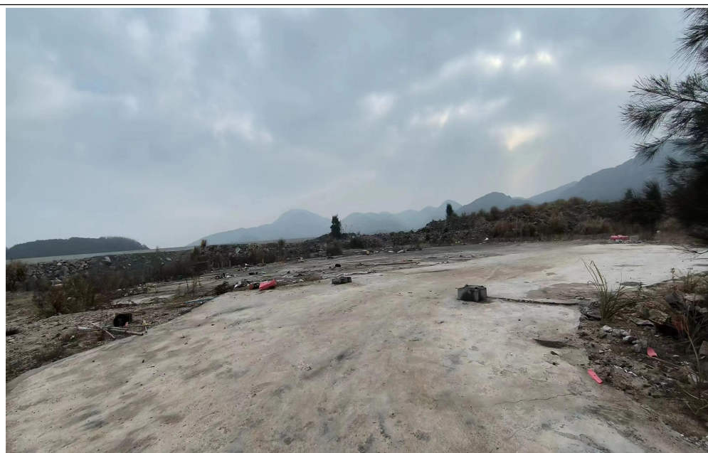
临时设施区场地恢复
