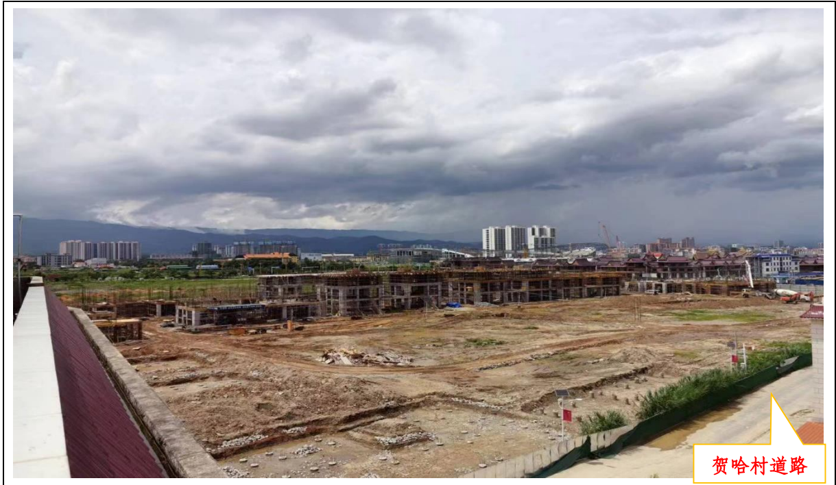
项目区整体现状
