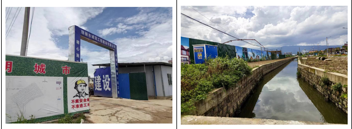
施工出入口现状
