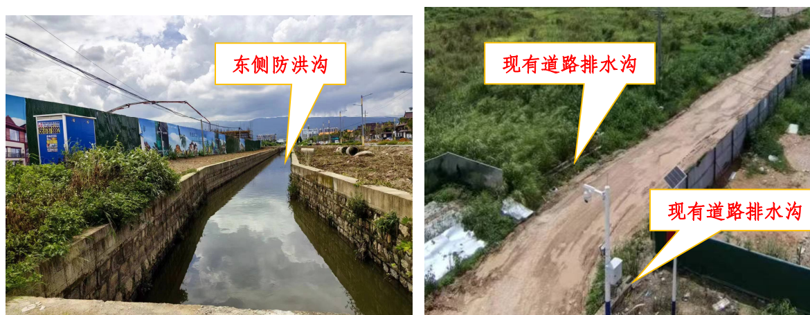
图 2-2 项目区周边排水设施现状
