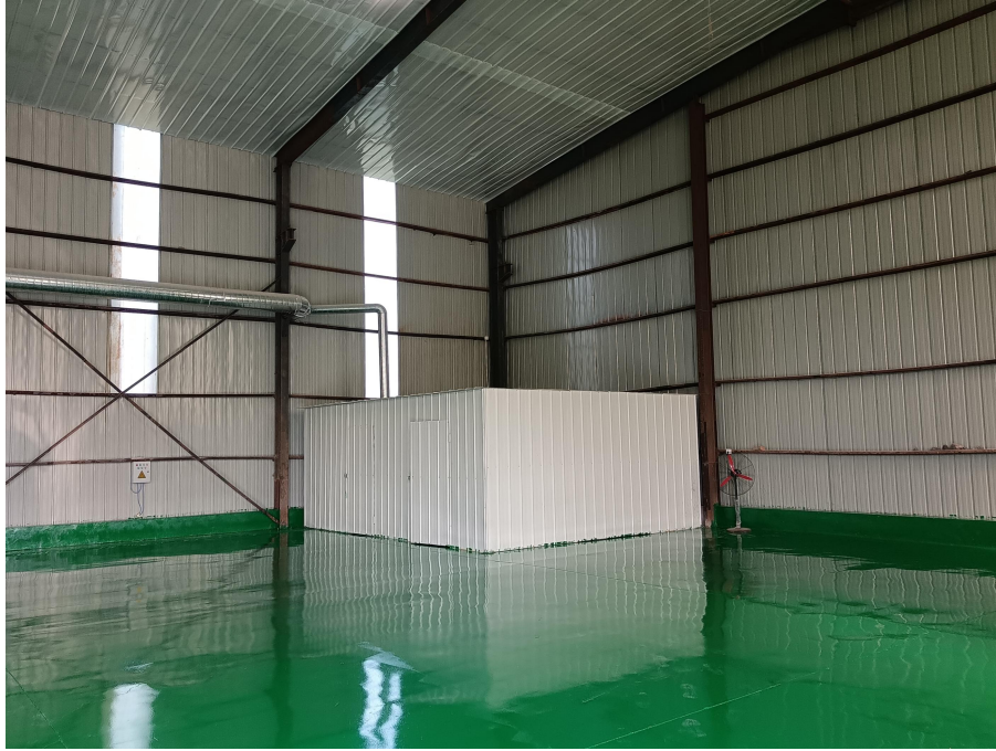
II类废铅蓄电池存放区、危废间
