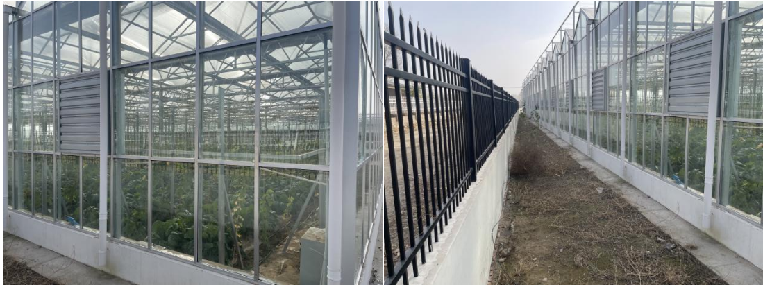
图 1-3 构建筑物区现状
