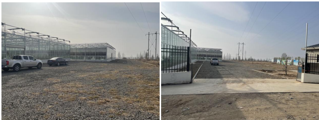
图 1-4 进场道路现状
