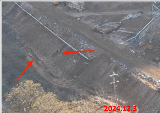
K21+800 西坡隧道出口临建边坡覆盖不到位、导致坡面存在侵蚀沟。
