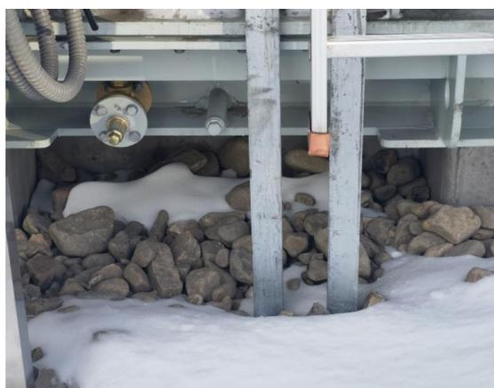
二号主变下碎石铺盖及减震基础
