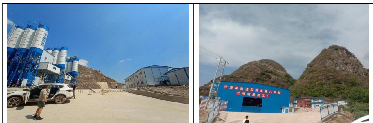
施工营场地区现状
