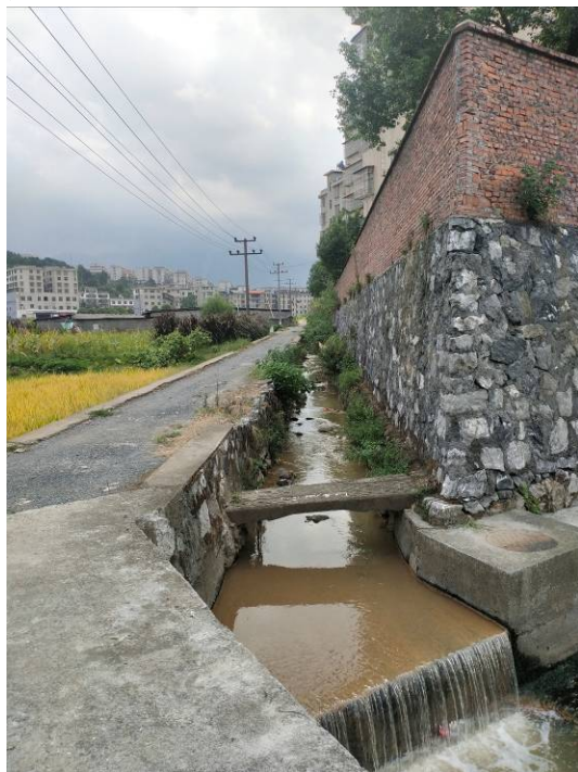
城市污水进口
