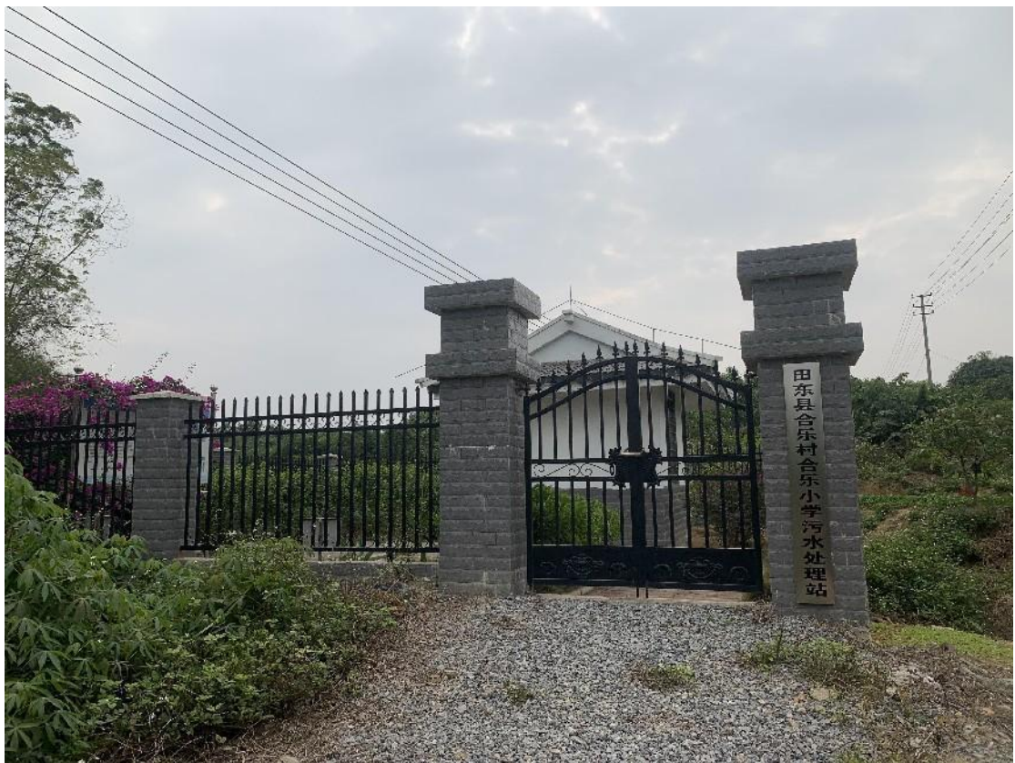
污水处理站现状照片
