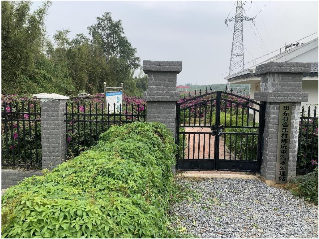
污水处理站现状照片
