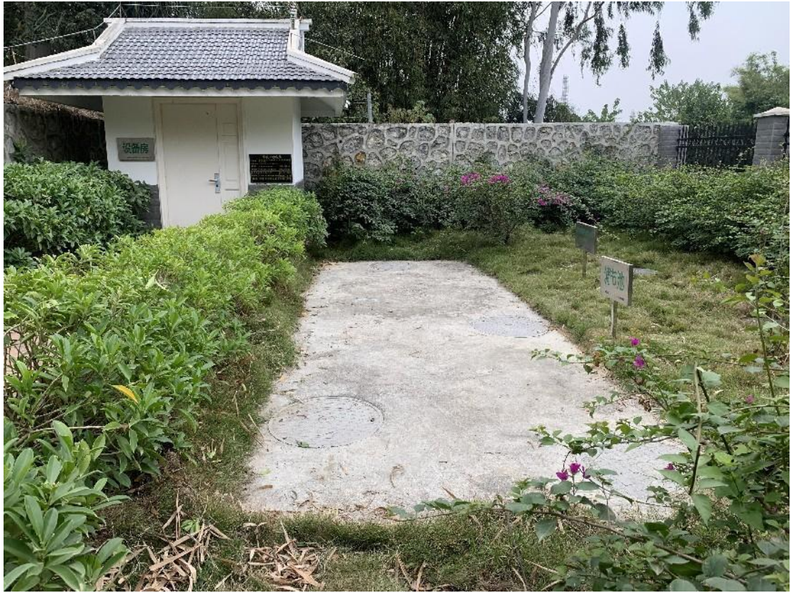
污水处理站景观绿化照片
