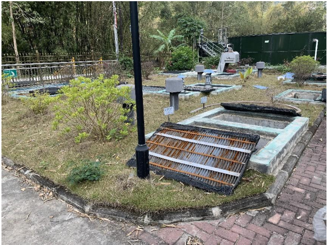
污水处理站景观绿化照片
