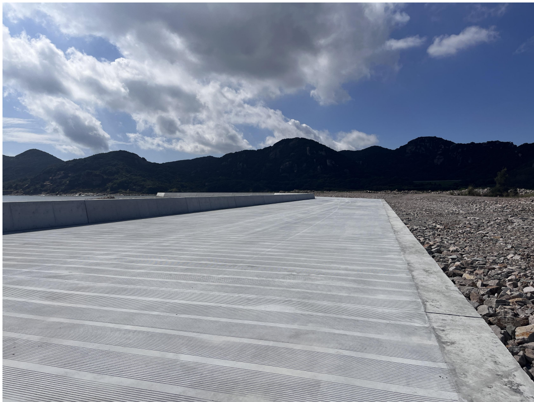
主体工程施工场地情况（2023 年第三季度）
