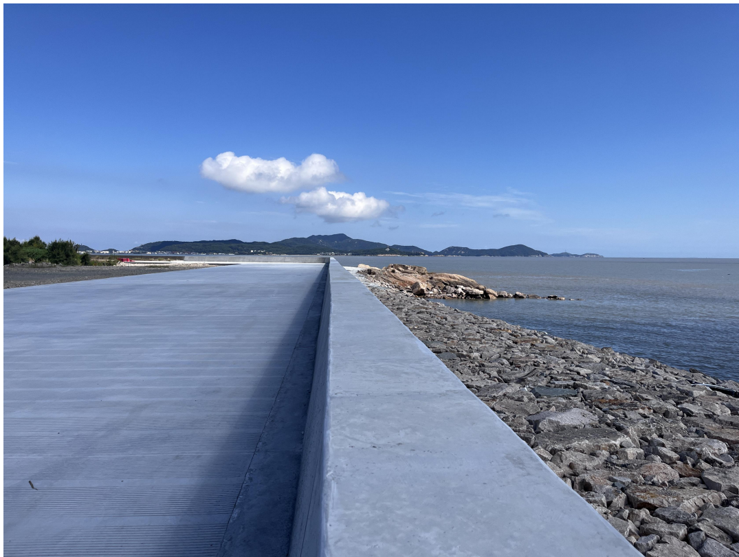
主体工程施工场地情况（2023 年第三季度）
