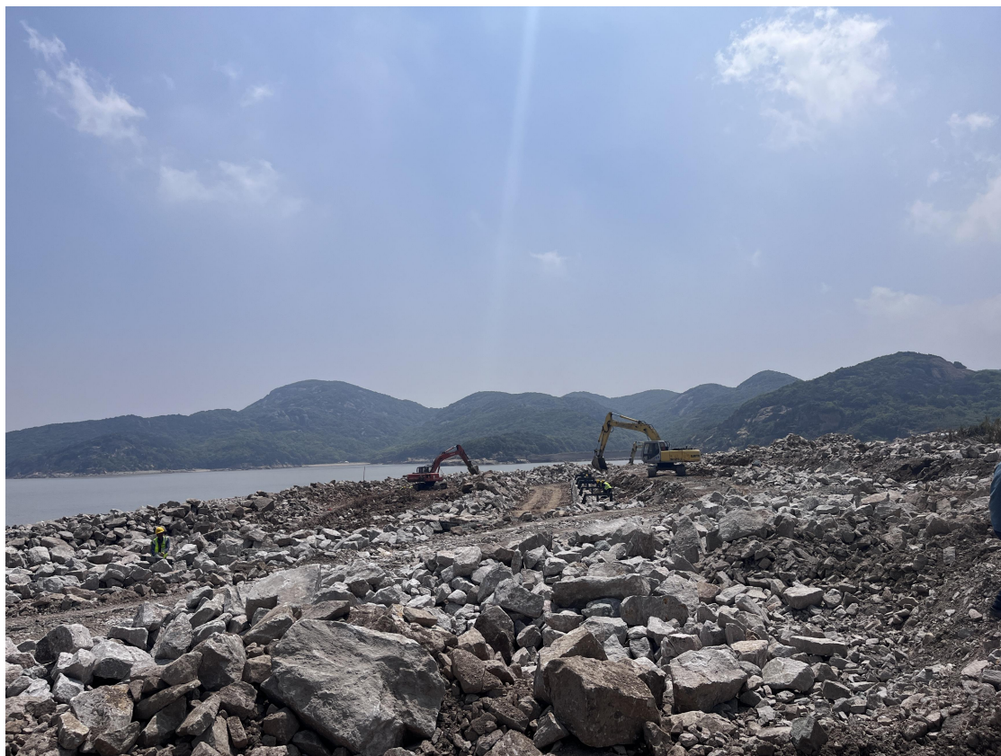
主体工程施工场地情况（2023 年第二季度）
