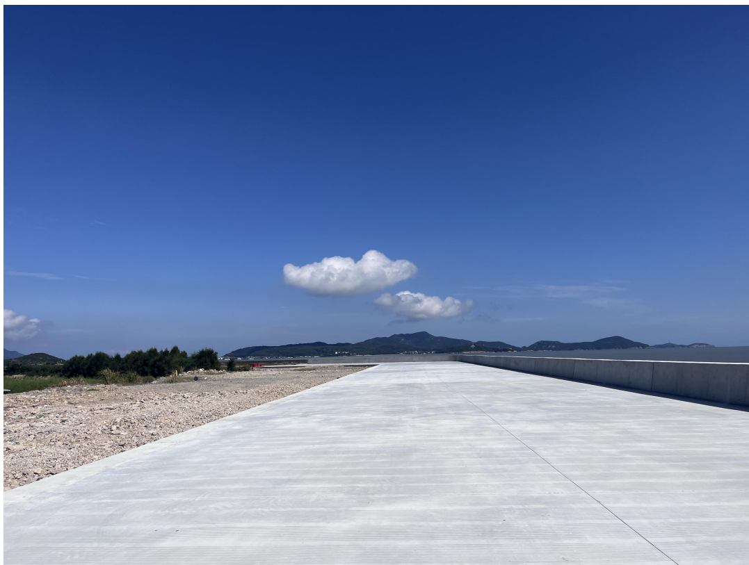
主体工程施工场地情况（2023 年第三季度）
