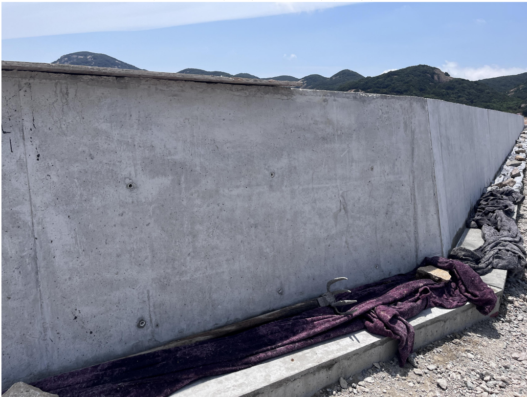
挡墙排水管（2023 年第二季度）
