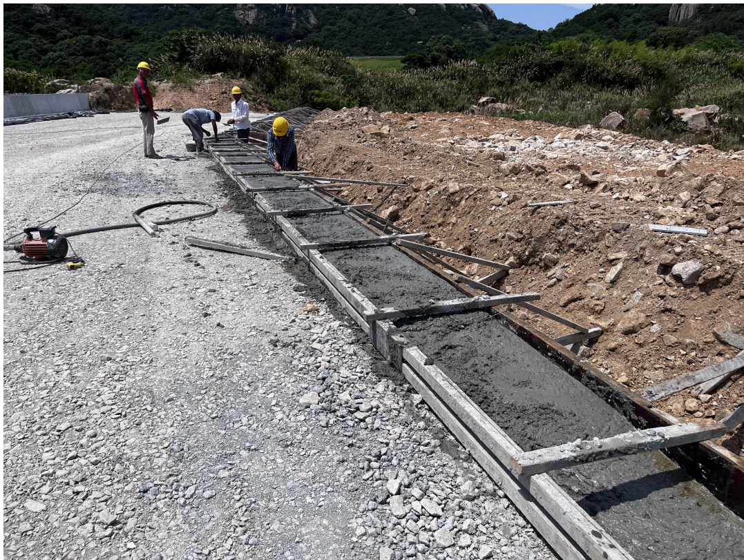
主体工程施工场地情况（2023 年第二季度）
