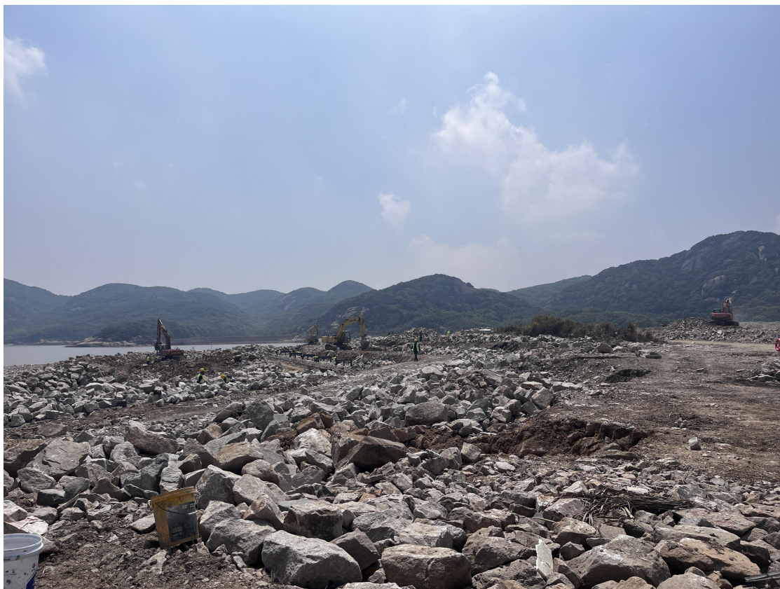
主体工程施工场地情况（2023 年第二季度）
