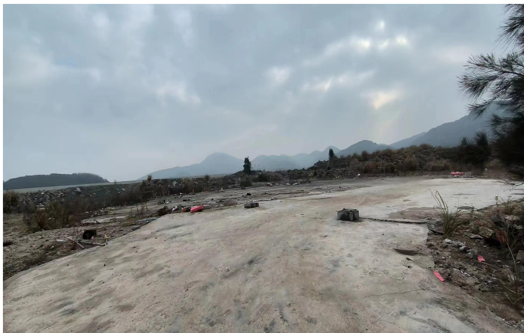
临时设施区场地恢复（2023 年第四季度）
