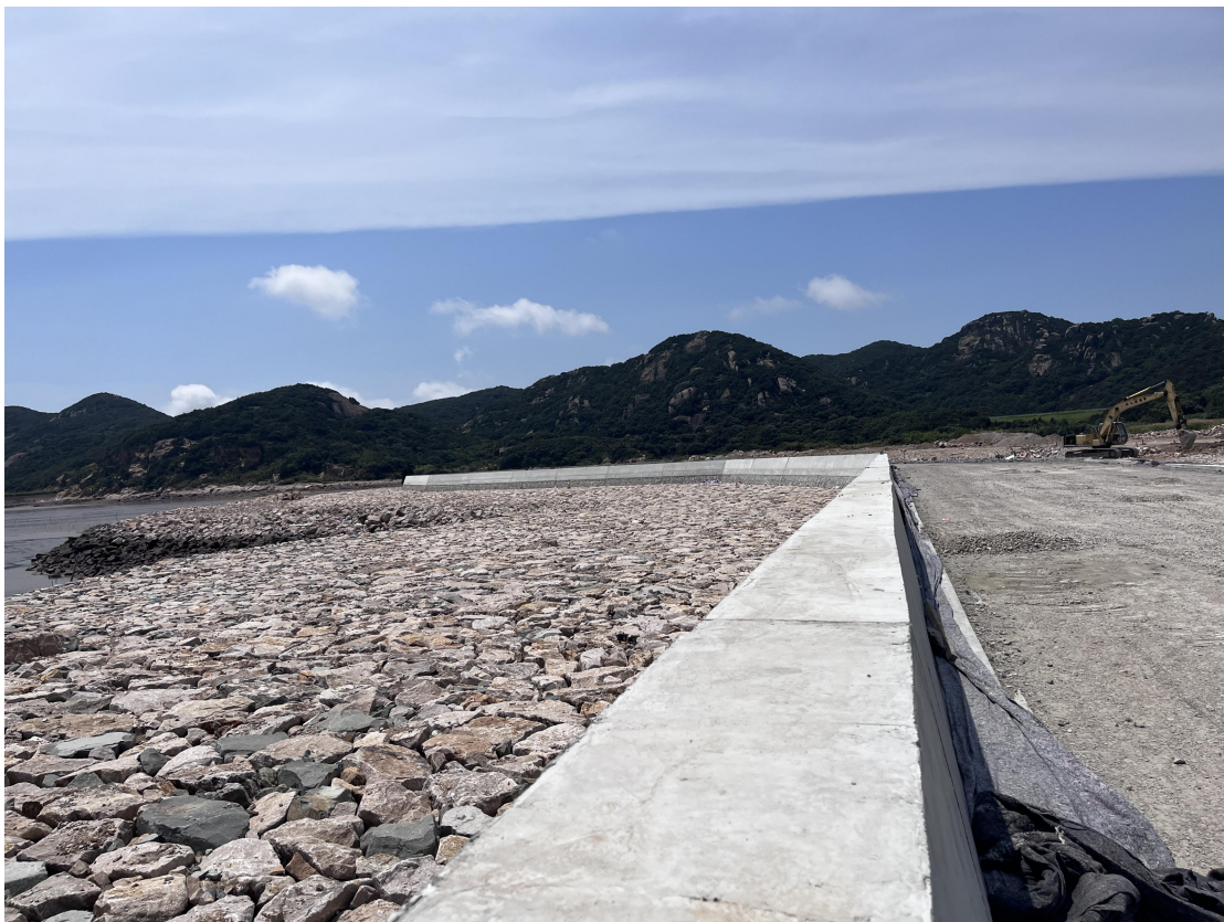
主体工程施工场地情况（2023 年第二季度）
