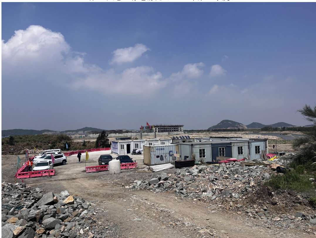
临时设施区施工现场（2023 年第二季度）
