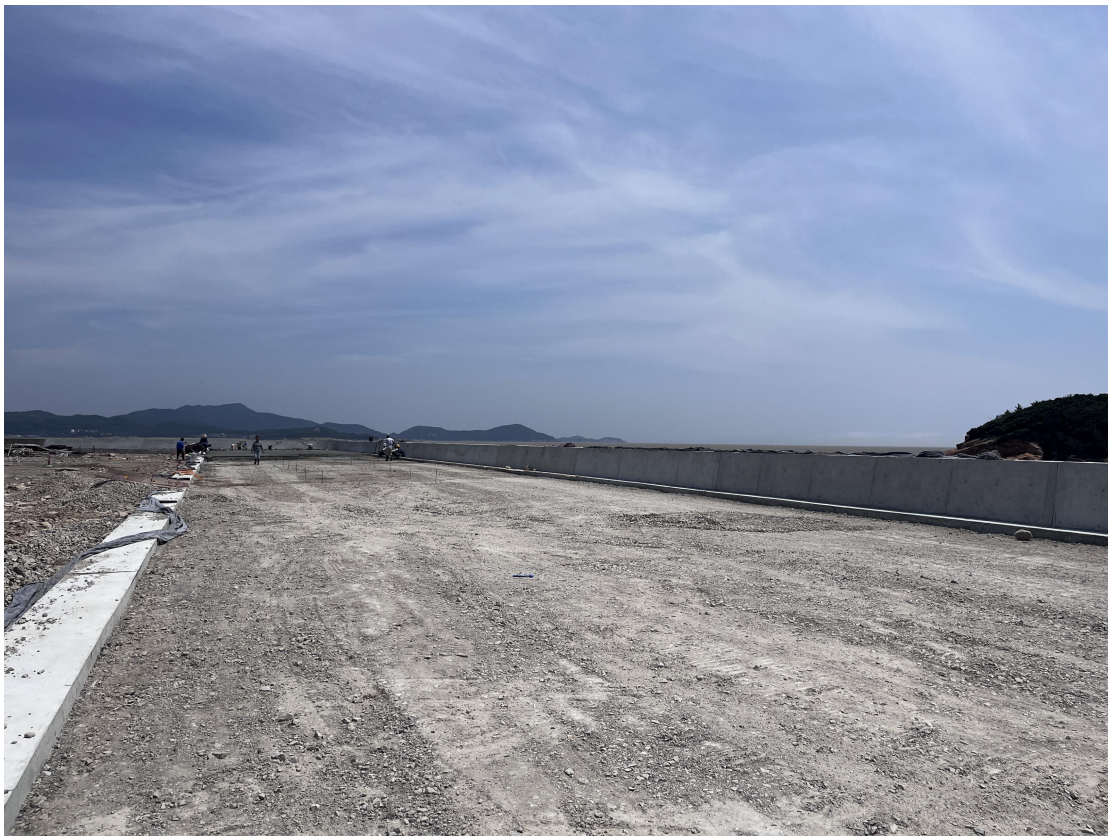
主体工程施工场地情况（2023 年第二季度）
