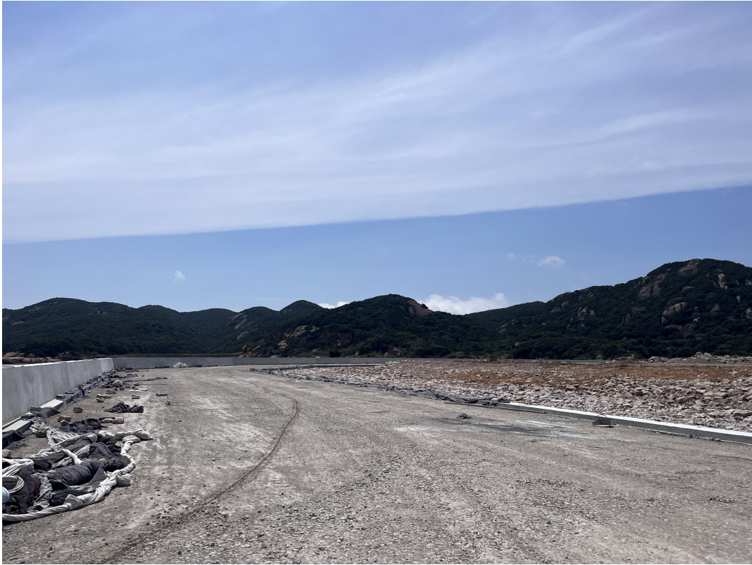
主体工程施工场地情况（2023 年第二季度）
