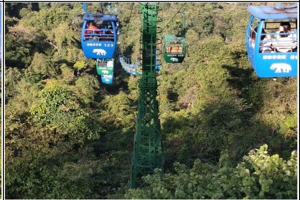
索道支架及吊箱
