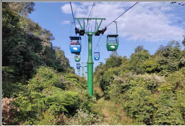
索道支架及吊箱
