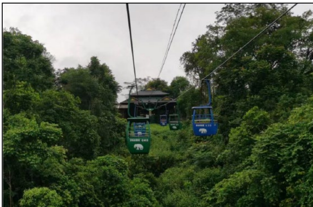
图 2—6 索道上站现状图
