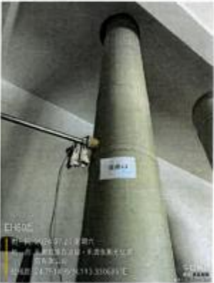
EH60 排气筒处理后 07月20日
