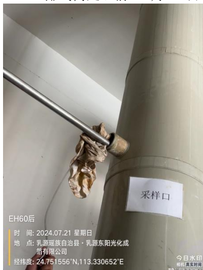
EH60 排气筒处理后 07月21日
