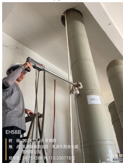
EH58 排气筒处理后 07月18日
