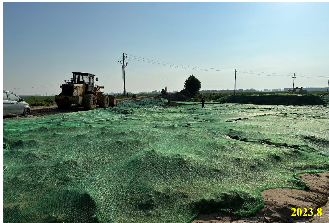
路基裸露面覆盖
