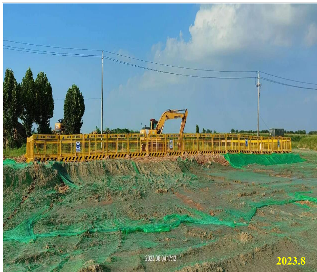
路基裸露面覆盖
