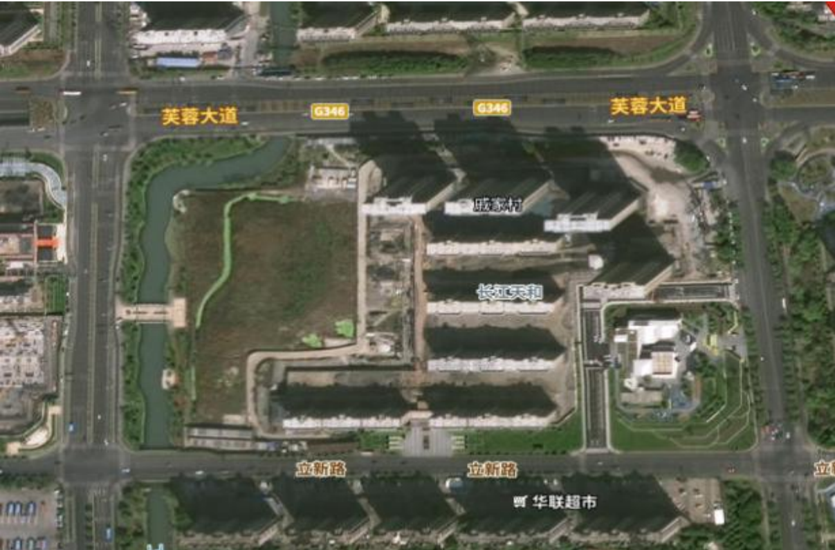
项目区建设后影像图（2024年）
