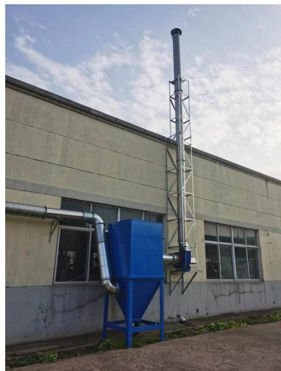
破碎废气处理设施“袋式除尘装置”
