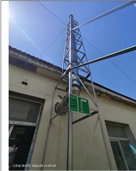
投料、磨粉废气处理设施及排气筒
