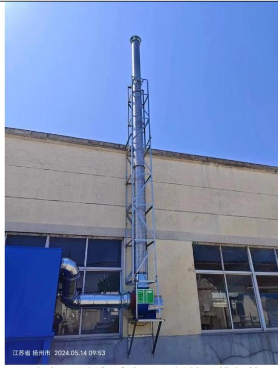
破碎1、破碎2废气处理设施及排气筒
