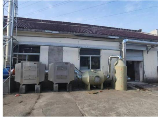
造粒有机废气处理设施“碱喷淋+除雾器+二级活性炭吸附装置”
