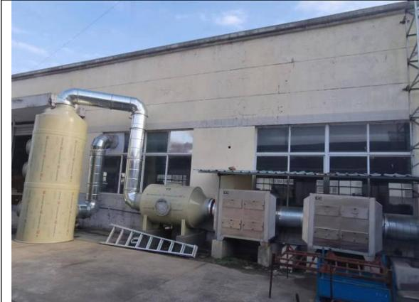
注塑、挤塑有机废气处理设施“碱喷淋+除雾器+二级活性炭吸附装置”
