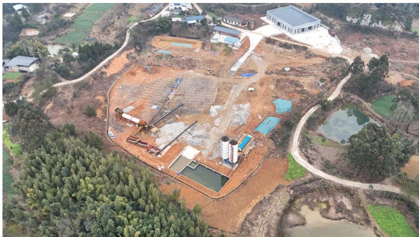
图 2.1-2 项目建设现状
