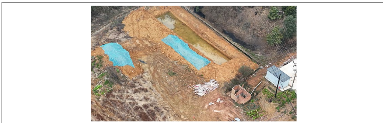
图 3.2-2 蓄水池现场照片
