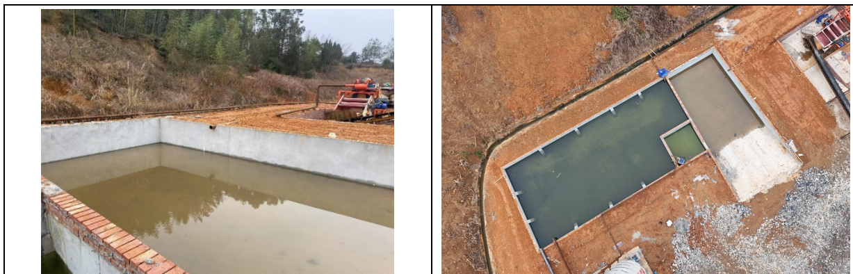
图 3.2-1 沉淀池现场照片
