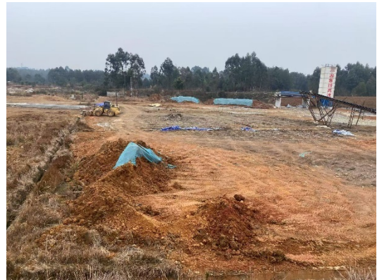
项目建设场地现状照片四
