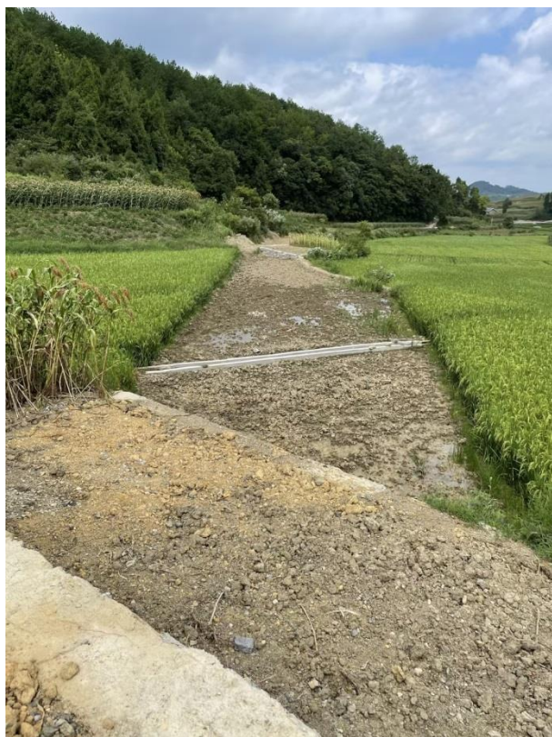
龙岩水库片区新建寺塘湾支管
