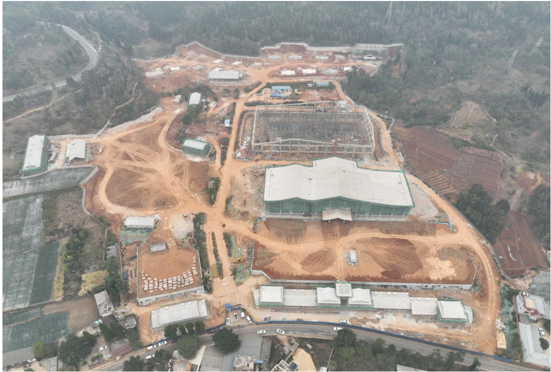
项目区情况（2024年12月）
