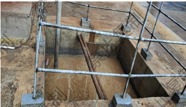
碱炉废水改造池
