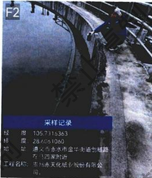
新建污水处理站出口
