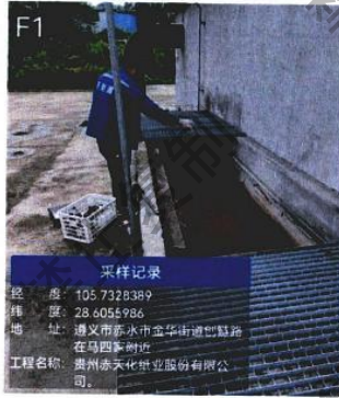
新建污水处理站进口
