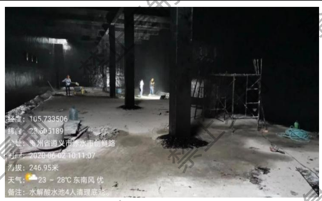
施工期防渗照片
