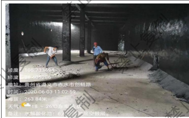
施工期防渗照片
