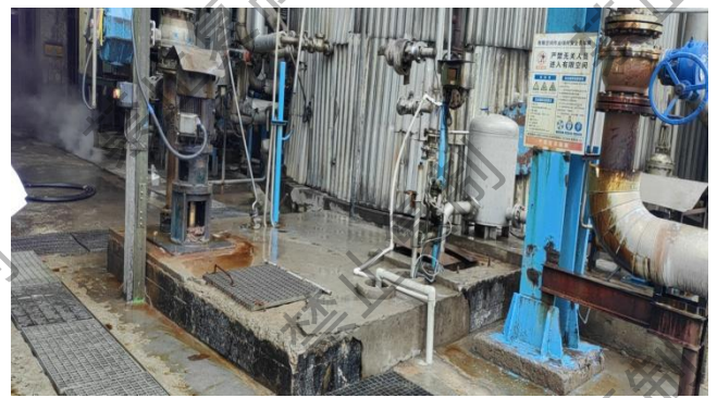
制浆车间废水收集池
