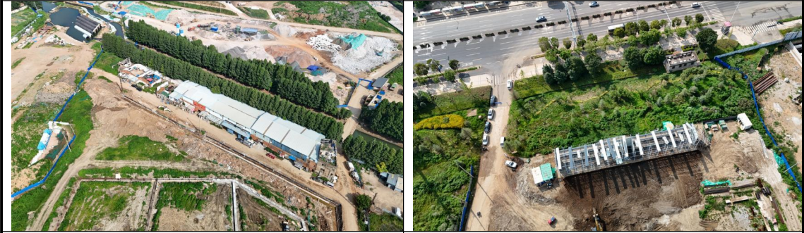
项目区西侧情况
