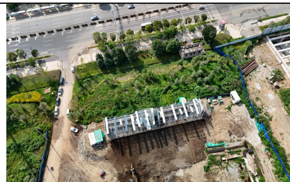
项目区东侧情况
