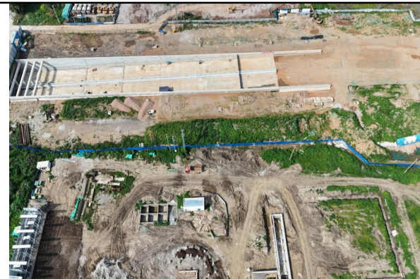
项目区南侧情况
