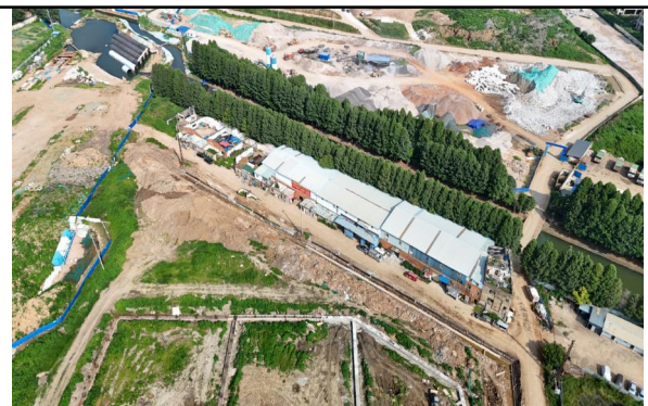
项目区西侧情况
