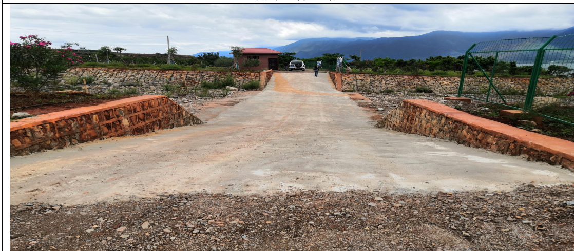
河门口过水路面
