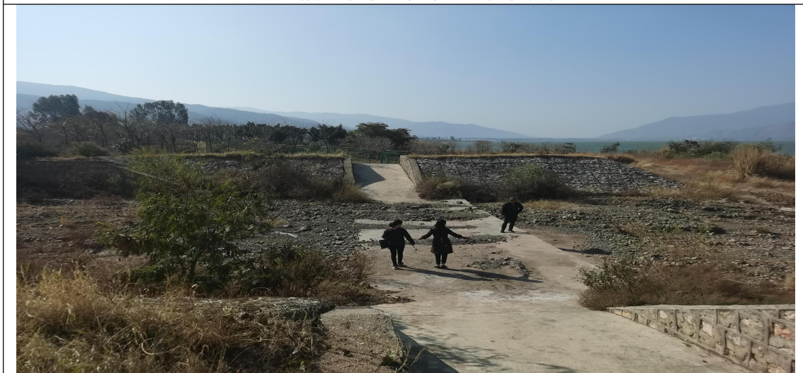
河道坝体两侧植物种植现状
