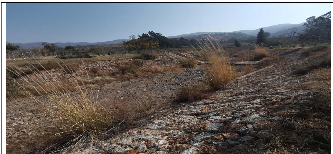
土堤鹅卵石护坡及植草、藤护坡现状
