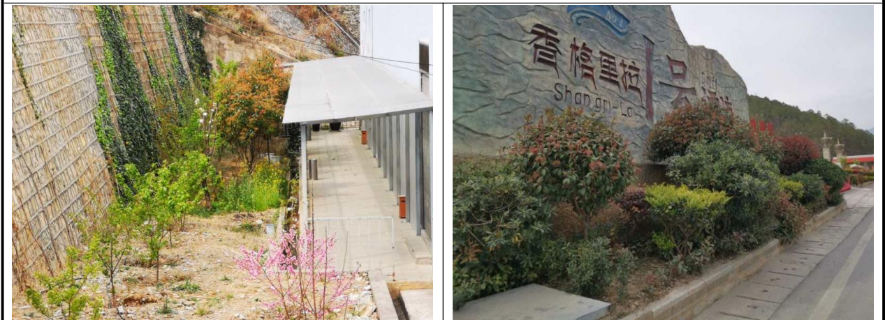
游客服务中心西侧挡墙、排水沟
