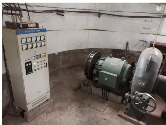
图 4-7 厂房内部现状图
