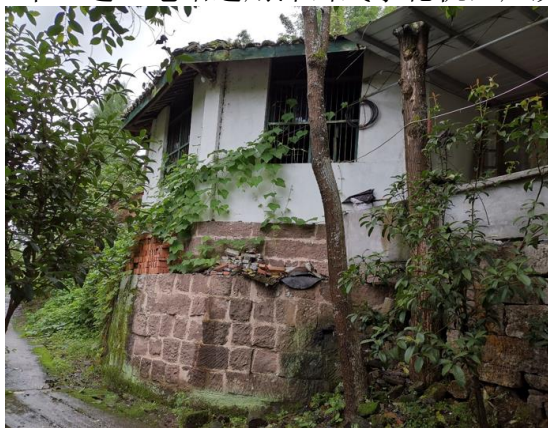
图 4-6 厂房外部现状图
