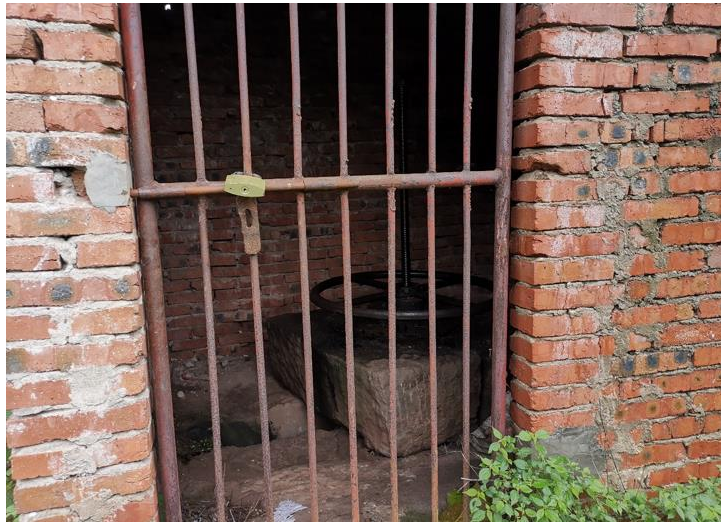
图 4-4 取水闸现状图
