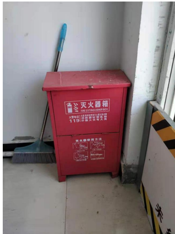
在线监控室灭火装置
