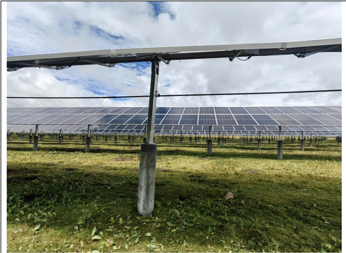
光伏支架地面恢复情况
