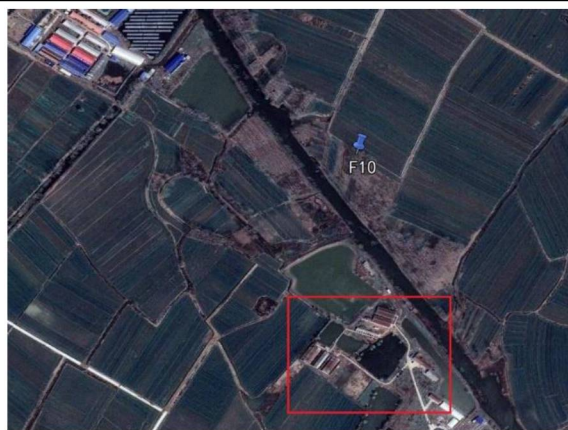
F10 风机南侧建筑卫星地图
