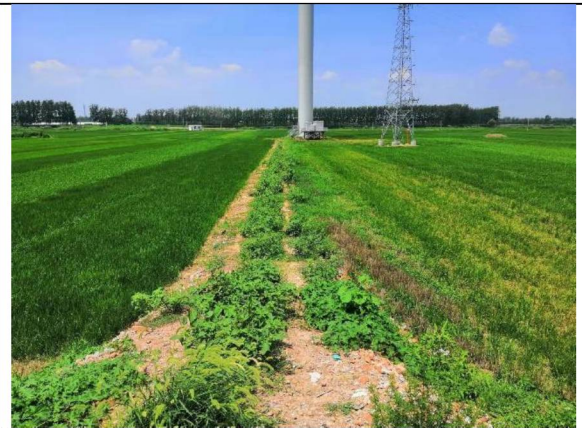
风机吊装场地复耕
