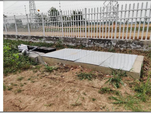
地埋式污水处理设施
