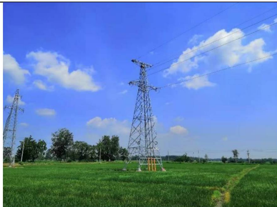
集电线路铁塔施工场地复耕
