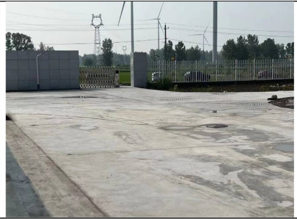
升压站站内硬化
