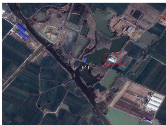
F11 风机东侧建筑卫星地图
