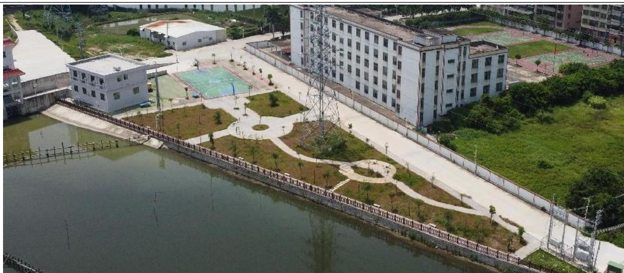
图 5 主体工程施工区--景观节点
