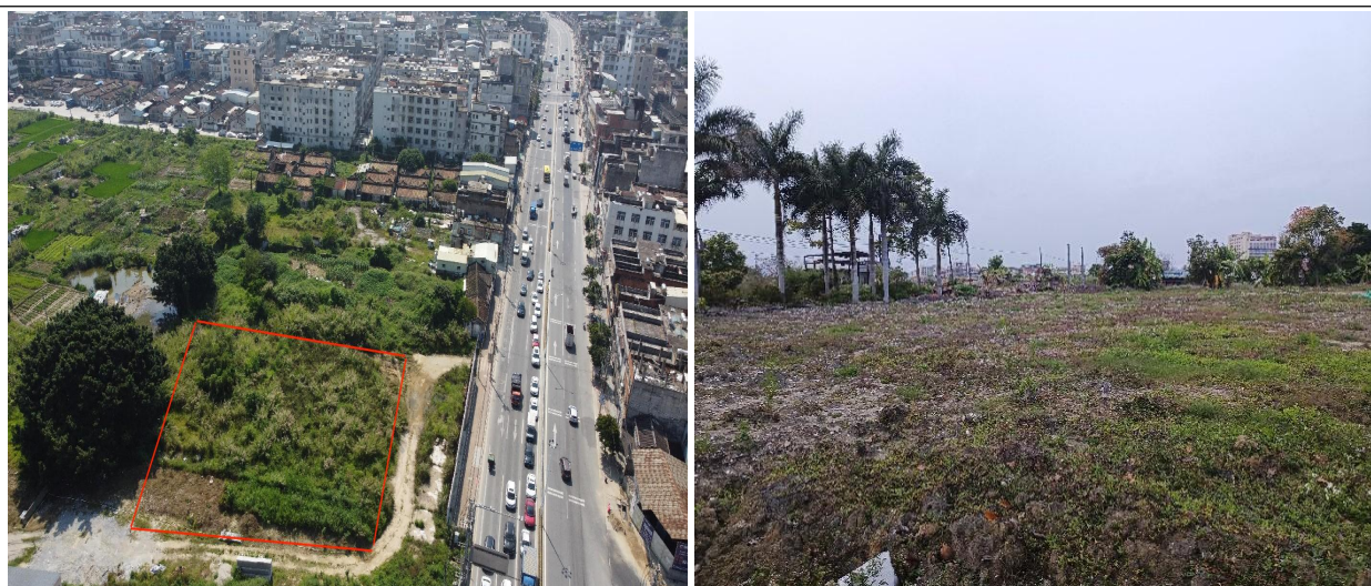
图 6 施工工区土地整治、撒播草籽
