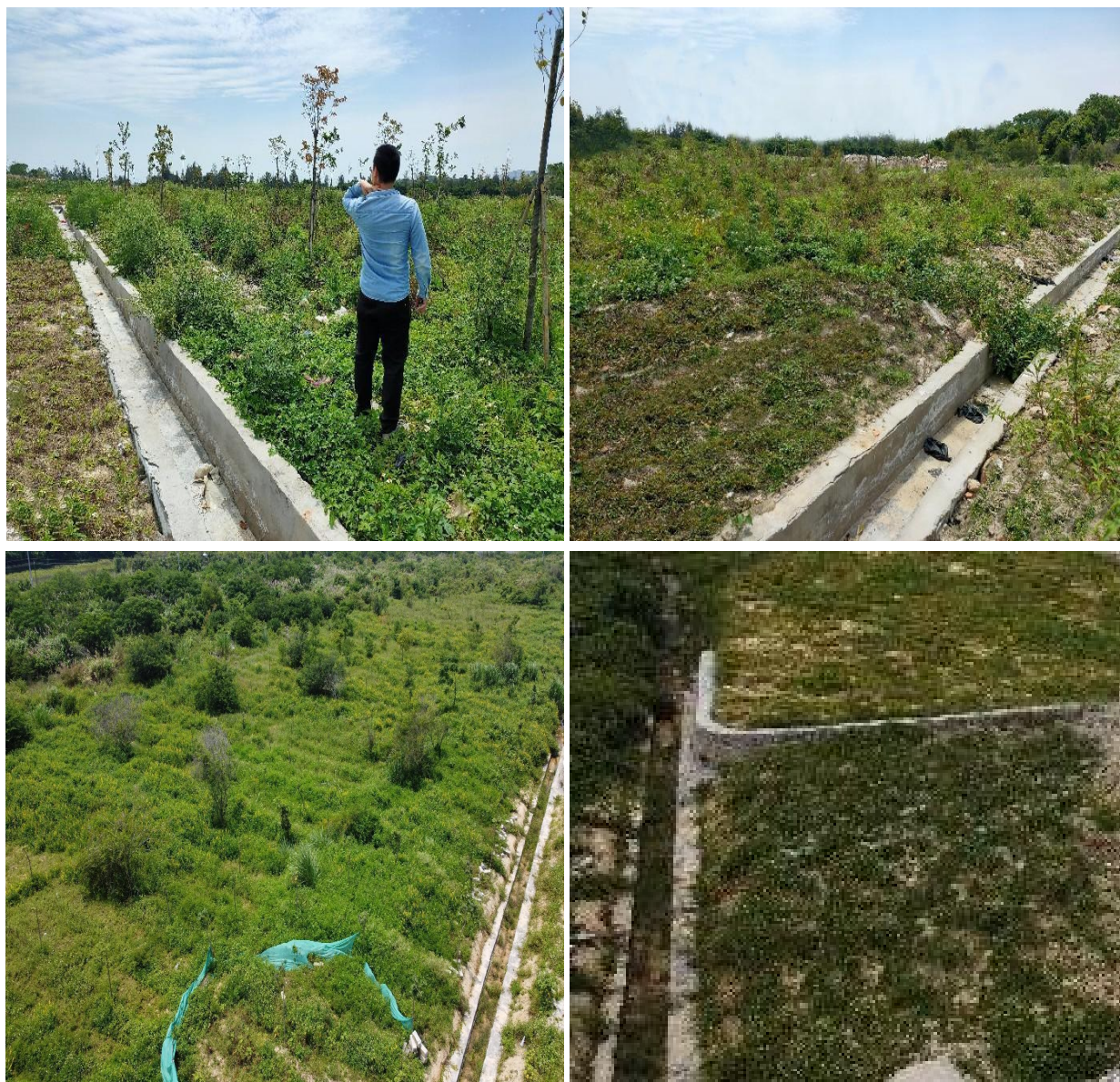
图 8 弃渣场区植被绿化、拦挡、排水等
