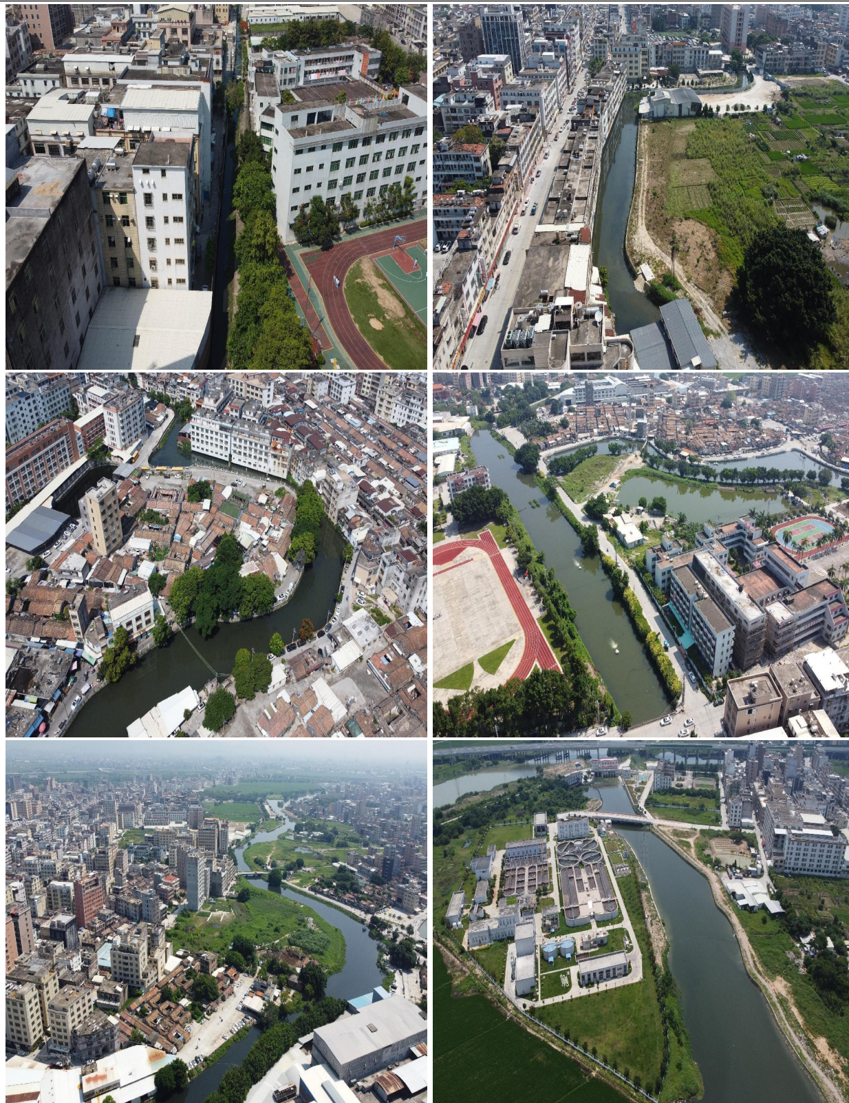
图 1 主体工程施工区--陈店内溪干流
