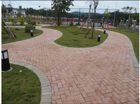
道路广场区现状
