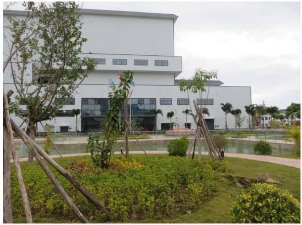
主体（建）构筑物区现状
