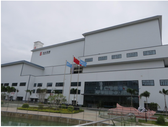
主体（建）构筑物区现状
