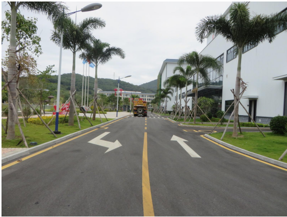
道路广场区现状
